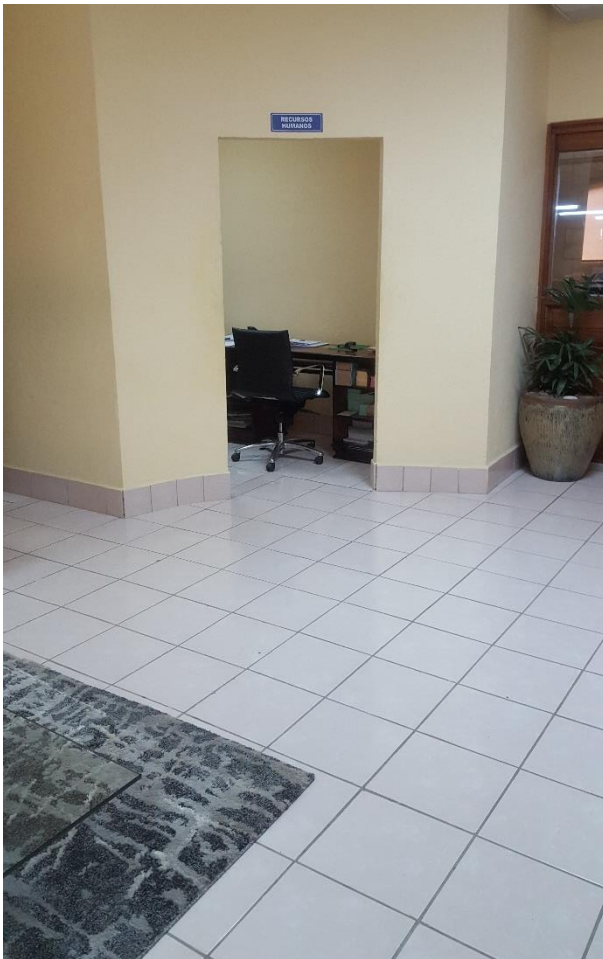
Ilustración 37, Riesgo Caída de persona al mismo nivel
