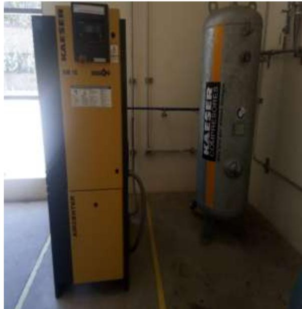
**Figura 17 Compresores de aire**
