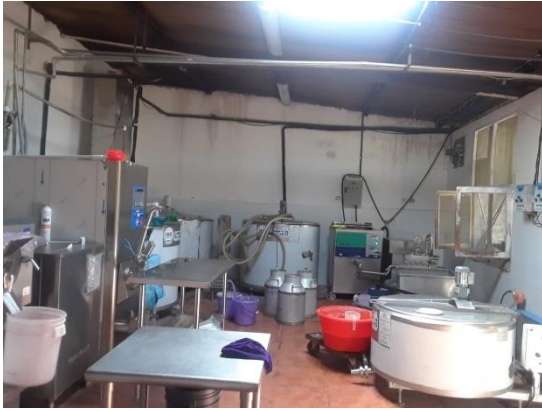
Figura 49. Piso en buen estado del área de producción.
