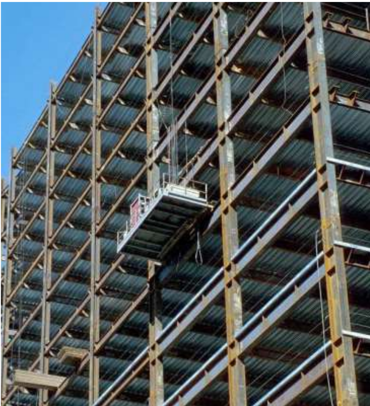
Figura 2: Sistema de Marcos Resistentes a Momentos. (Fuente: Presentaciones AISC)
