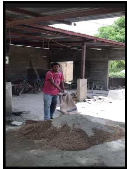
Fotografía 5: Mezcla de materiales
