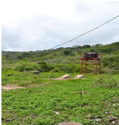
Figura 32. Tanque de almacenamiento de agua
