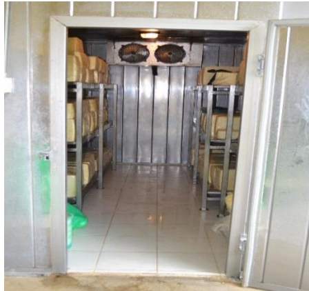
Figura 18. Vista de la entrada del cuarto frío
