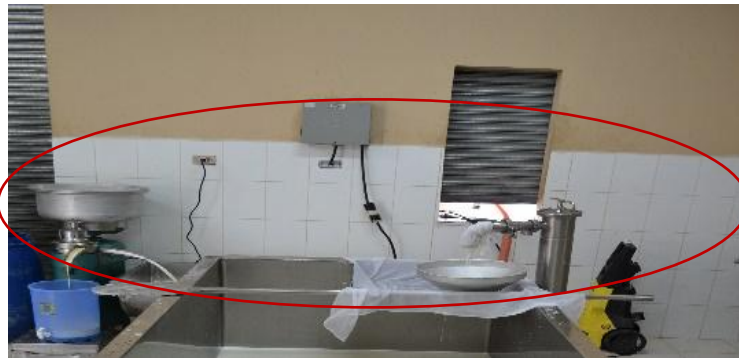
Figura 21. Vista de las paredes del área de proceso
