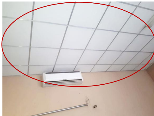
Figura 23. Vista del techo de la planta
