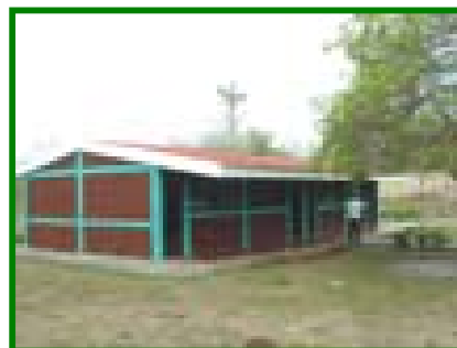
Vista posterior de las Aulas de clases
