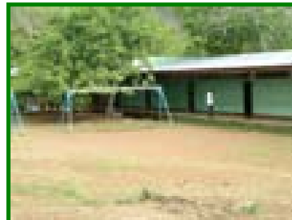
Vista del Agrupamiento N° desde el patio del colegio.
