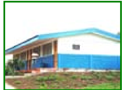
Vista del pabellón de clases, agrupamiento (1).
