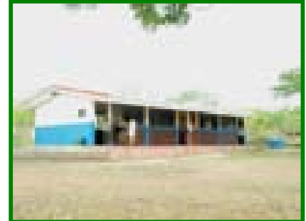
Vista externa de las Aulas de Primaria, agrupamiento (2)
