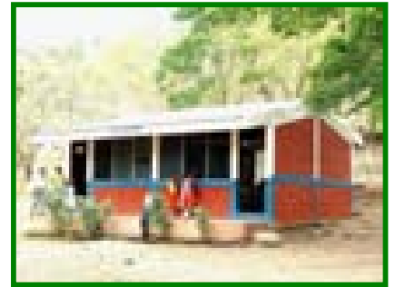
Vista externa de la escuela
