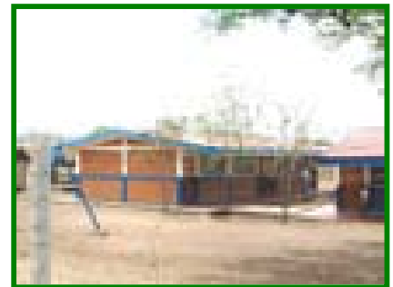
Vista exterior de los pabellones de clases, Agrup. (2)
