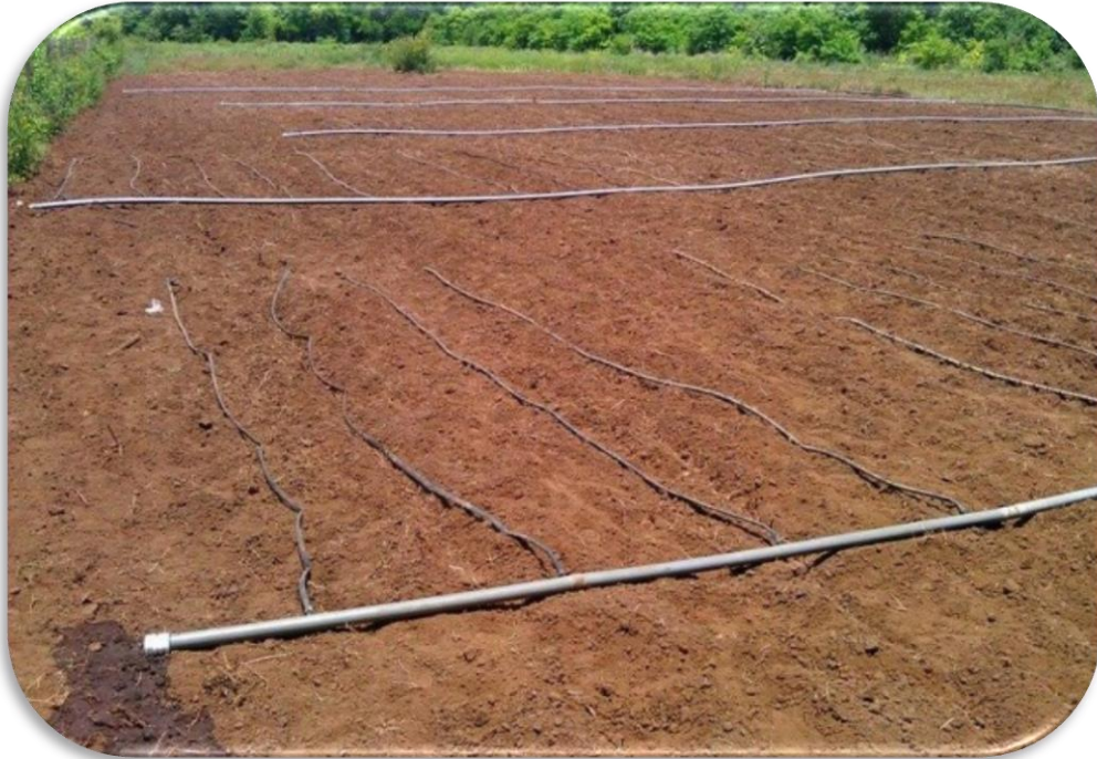
Fotografía 9: Instalación del sistema de riego
