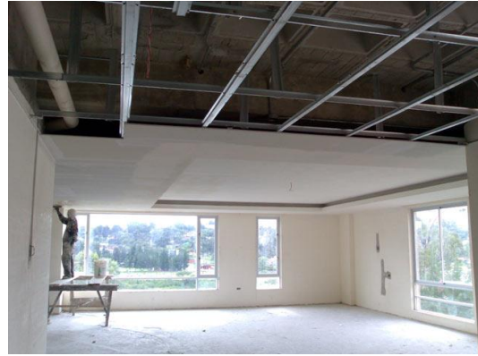
Figura 4. Cielo raso en proceso.
