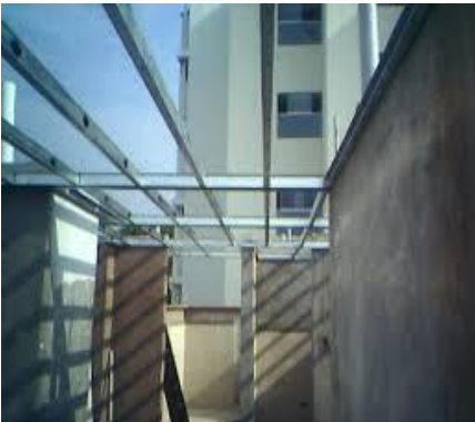
Figura 7. Estructura de techo gypsum.
