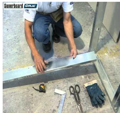
Figura 8. Ajuste de perfilería
