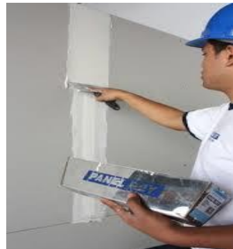
Figura 11. Sellado entre juntas con cinta. Figura 12. Aplicación de pasta.
