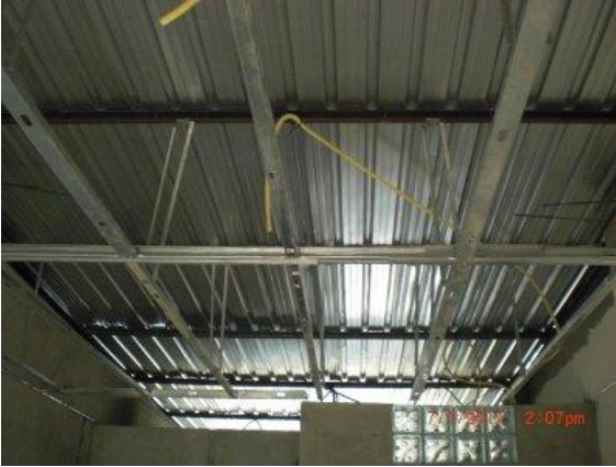
Figura 3. Estructura de cielo raso
