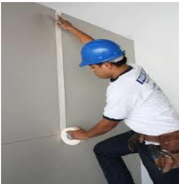
Figura 11. Sellado entre juntas con cinta. Figura 12. Aplicación de pasta.
