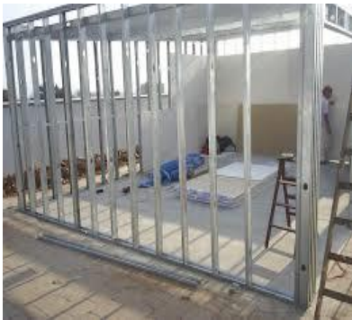
Figura 1. Estructura de pared gypsum
