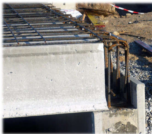
Figura 4.8 Conexión húmeda en espera del colado de sobrelosa. Tomado de Google Imágenes
