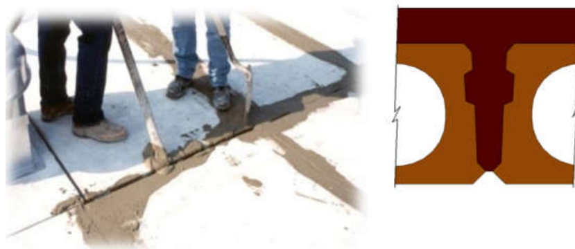
Figura 4.3 Losa Alveolar prefabricada. Tomado de (Company, 2015)
