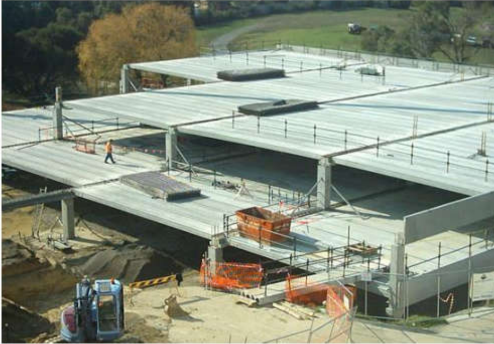
Figura 4.4 Construcción Típica con losas alveolares o extruidas. Tomado de Google Imágenes.
