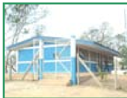
Vista de acceso principal, se observa el buen estado del agrupamiento 1.
