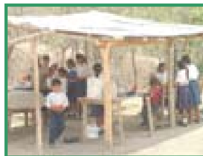
Vista de agrupamiento 2, se puede apreciar la falta de condiciones del mismo.
