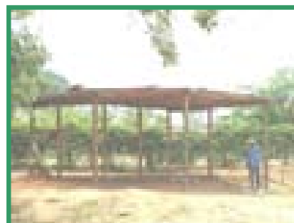
Vista frontal de la escuela, se observa la falta de condiciones de esta.
