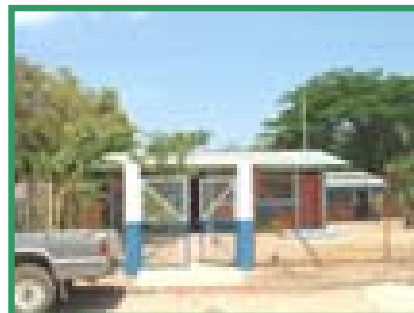
Vista principal de la escuela.
