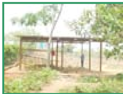
Vista panorámica de la escuela, la cual no cuenta con infraestructura adecuada.
