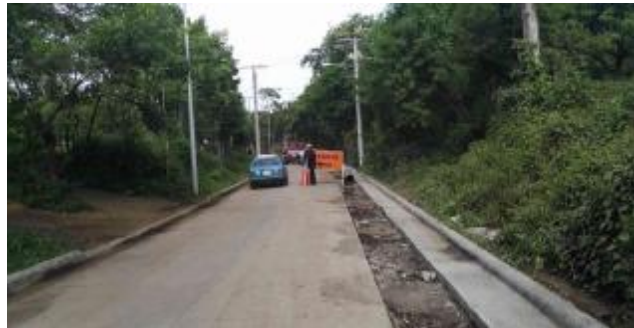
Foto 3: Carretera de concreto hidráulico En Buen estado pero sin andenes o ceras peatonales un peligro para los habitantes del sector
