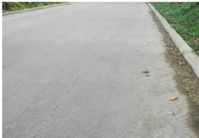
Imagen 62. concreto hidraulico en buen estado ,subtramo Ent. a Las Jaguitas- Ent.a Sabana Grande.
