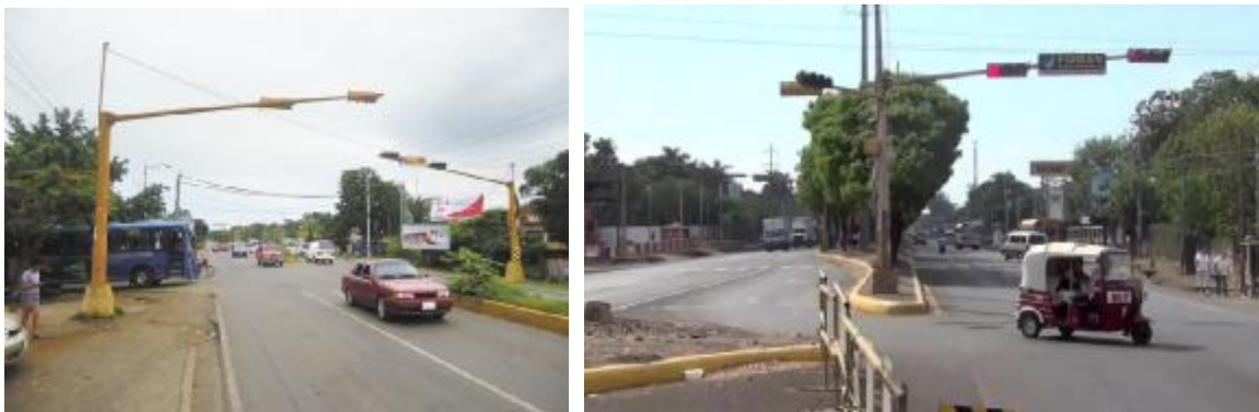
Foto 59 y 60: Semáforos entrada a Esquipulas levantamiento de campo.
