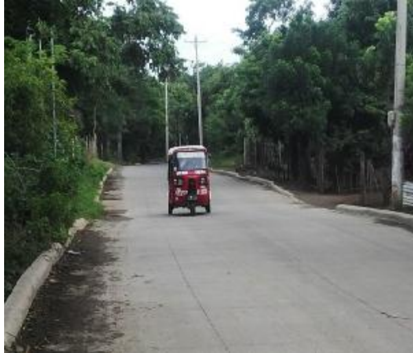
Foto 66.Vado en buen estado, subtramo Ent. Las Jagüitas – Ent. a Sabana Grande
