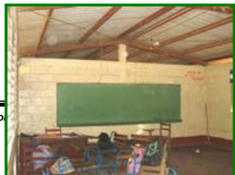
Vista interior de una de las aulas.
