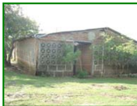
Vista de fachada de la escuela.
