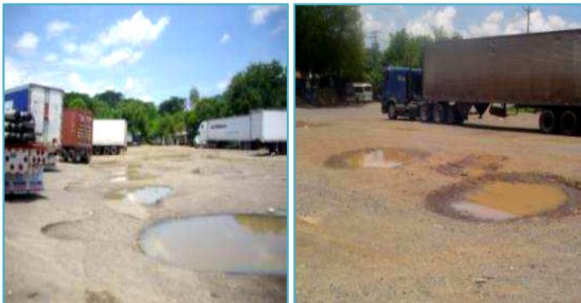
Área destinada para el estacionamiento de vehículos de carga, superficie de rodadura sin ningún recubrimiento de concreto asfáltico o hidráulico
