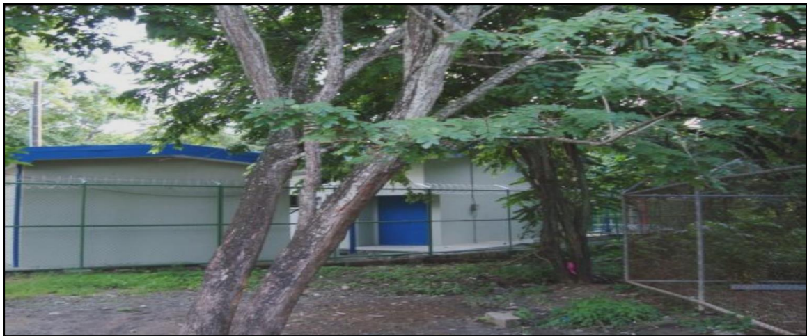
Figura 20 Instalaciones de comunicaciones y policía de drogas (CR).
