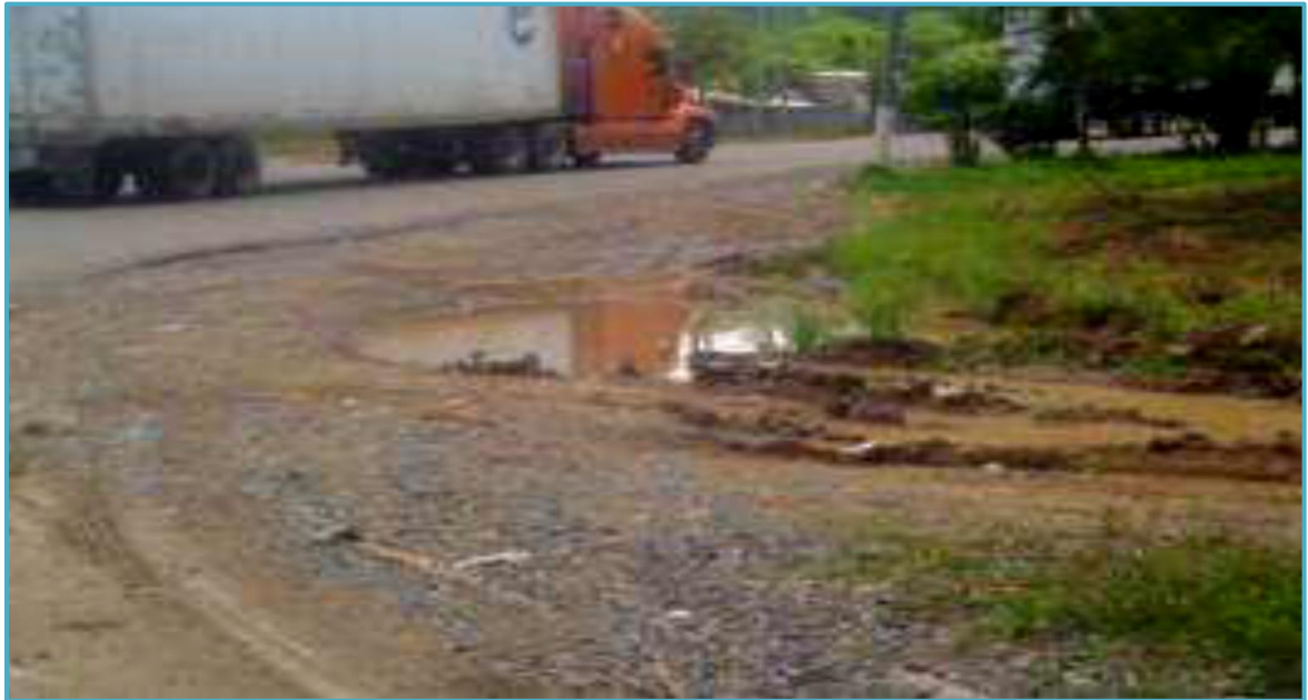
Encharcamiento a orilla de la vía
