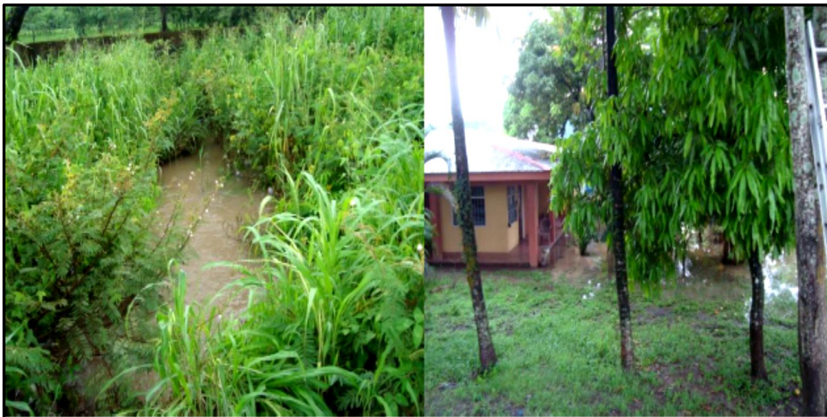
Figura 27 Oficinas del MAG con colapso después de las lluvias y canal drenante (meandro) que desfoga al Rio Sapoá (CR)
