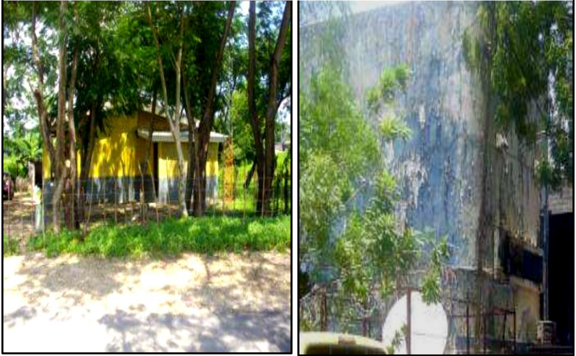
Figura 11 Puesto policial está ubicado dentro del paso fronterizo, entre área primaria y puente Guasaule.
