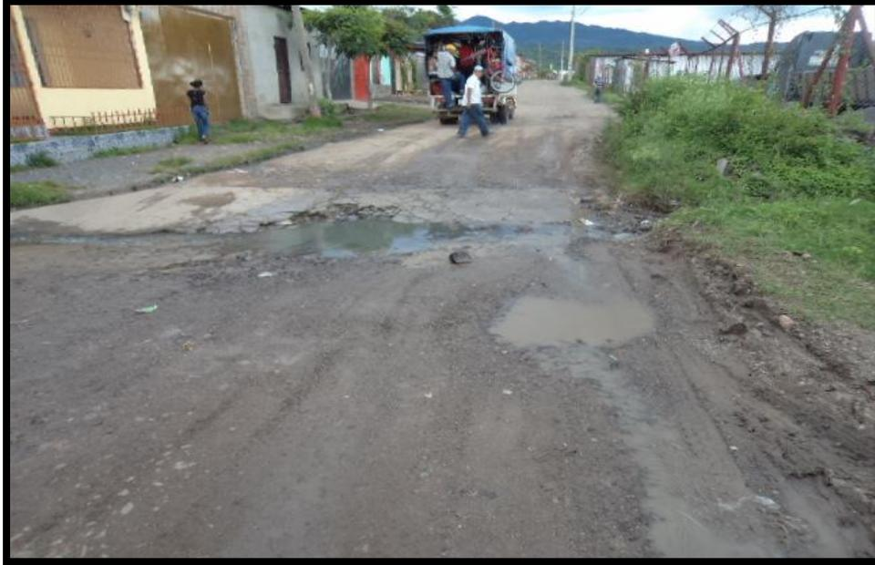
**Foto 2:** Tramo de camino donde no existe sistema de drenaje. Estación 0+400
