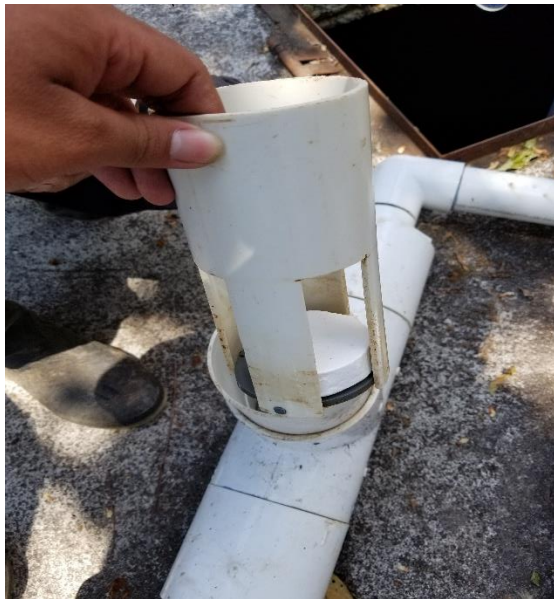
Imagen 1.15 Aplicación de pastilla de cloro en entrada del tanque
