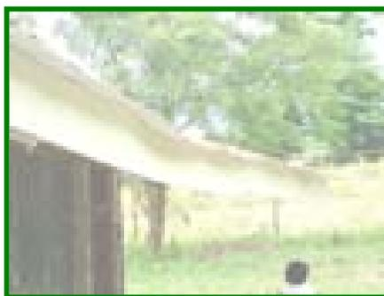
Vista del Agrupamiento 4, se aprecia el techo desnivelado. Requiere reparación.
