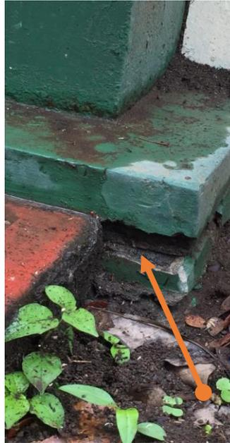
Lesión Mecánica: Desprendimiento de material por desgaste.
