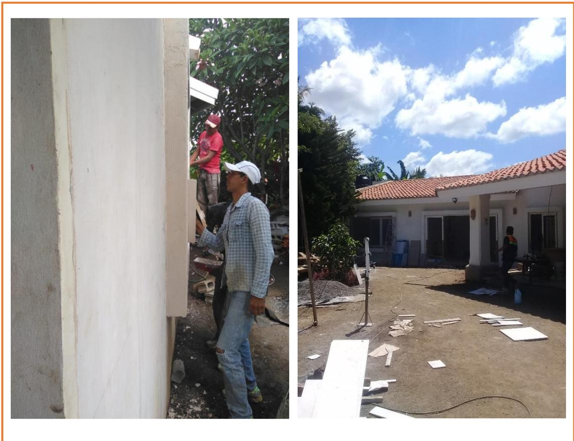
*Ilustración 23: Instalación de fascia de densglass con acabado thinset – Fuente LUARQUITECTOS*
