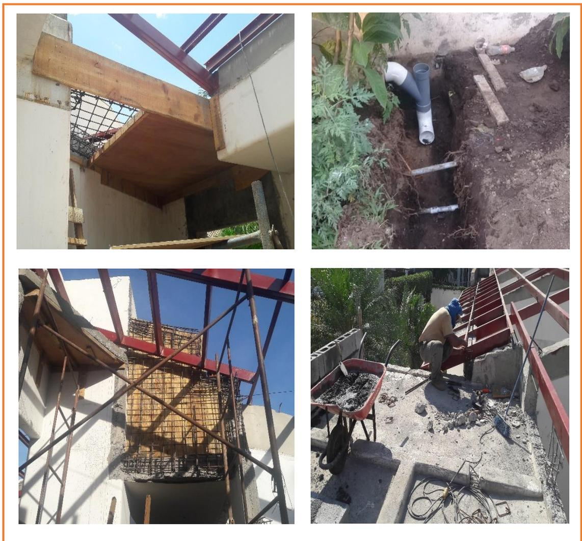
*Ilustración 13: Obras contractuales: Construcción de losa, construcción de pared culata, construcción de muro sobre losa existente y obras hidrosanitarias – Fuente propia*
