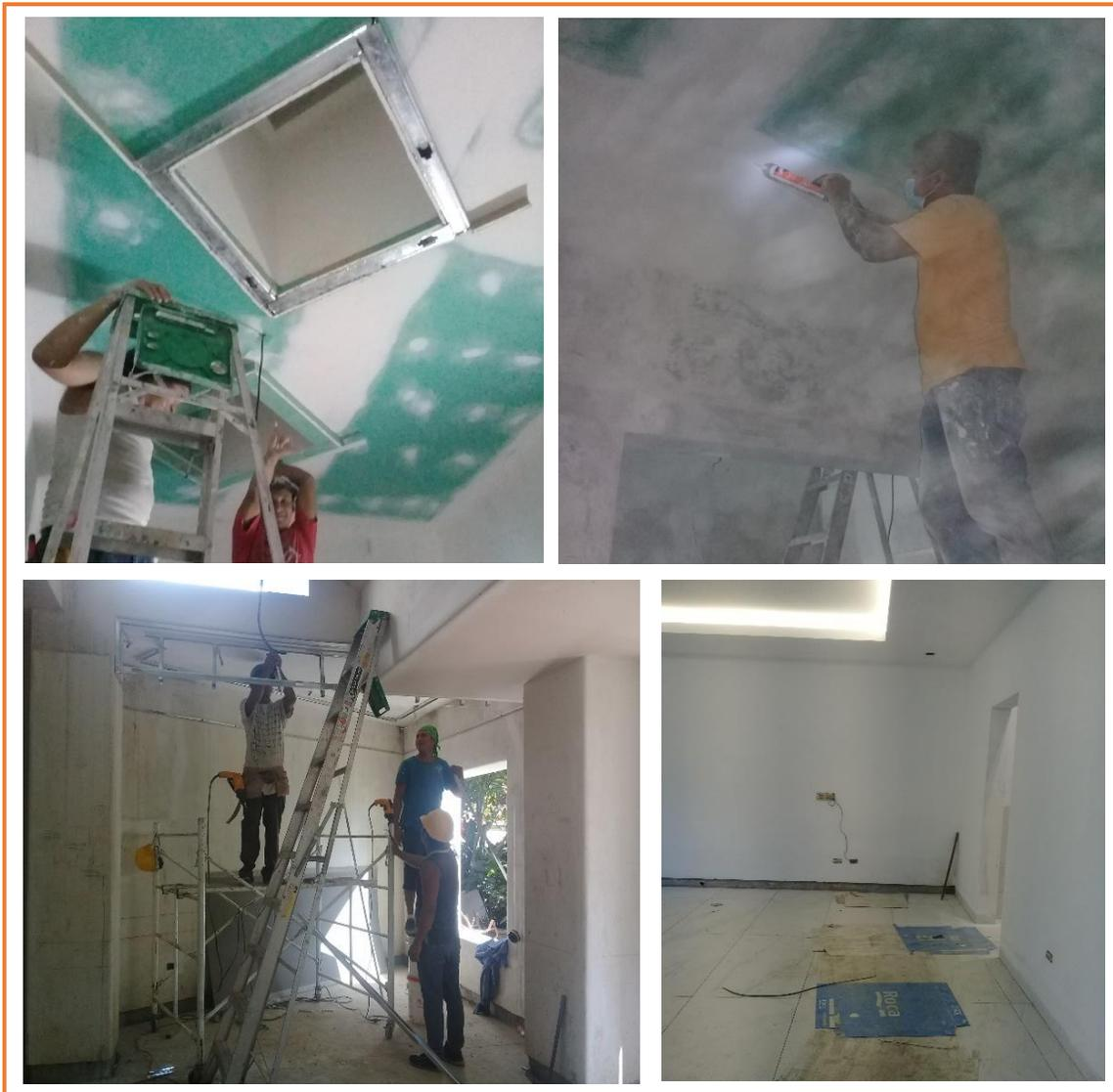
*Ilustración 24: Instalación de cielo falso tipo lucernario en área de vestíbulo, y Dormitorio principal, y en domos ubicados en área de servicio.*
