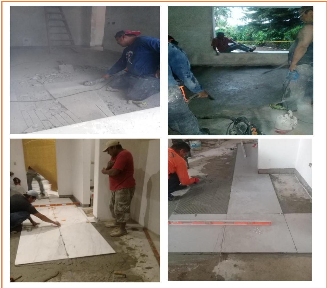
*Ilustración 20: Preparación de superficie de cascote nuevo para instalación de piso en Dormitorios, Sala familiar y Área de servicio.*
