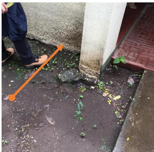
Lesión física: Erosión del terreno a causa de la caída brusca del agua de lluvia por ausencia de alero.
