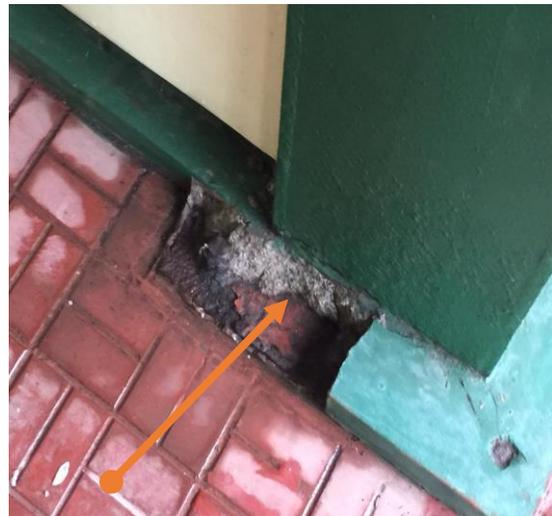
Lesión física: Desprendimiento de base de concreto en columna metálica.
