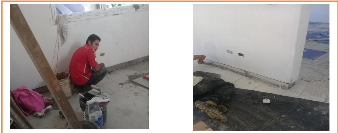
Ilustración 21: Instalación de rodapié empotrado en pared – Fuente LUARQUITECTOS
