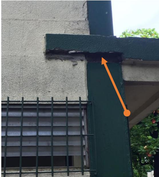
Lesión Mecánica: Desprendimiento de material por falta de adherencia
