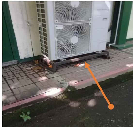
Lesión Química: Oxidación de bases metálicas por estar expuesto a la intemperie.
