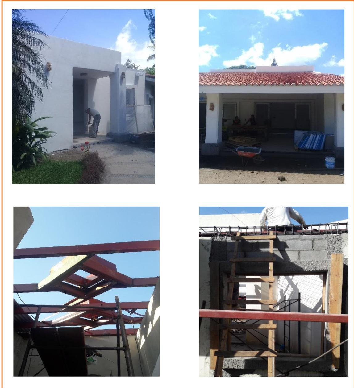
*Ilustración 16: Modificación en estructura de techo por construcción de domos, pared nueva para cerramiento de vestíbulo, construcción de muro sobre losa de acceso principal – Fuente propia*
