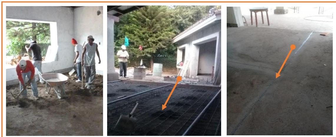
Ilustración 17: Preparación de superficie para llena de cascote nuevo – Fuente LUARQUITECTOS
