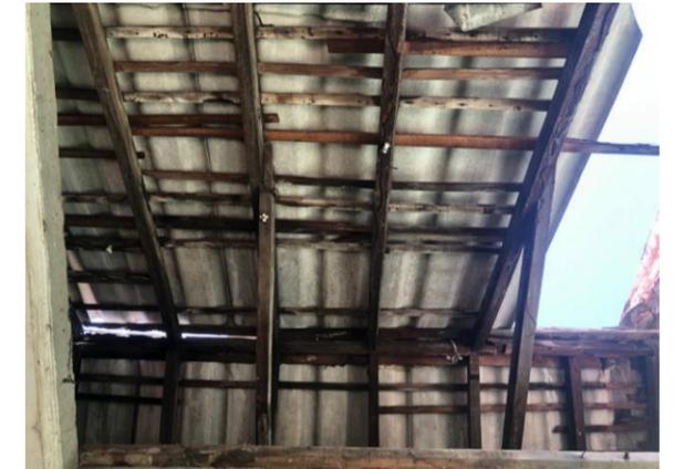
Imagen 126: Cubierta y estructura de techo colapsada en área de servicios sanitarios de piscina. Fuente: propia.
