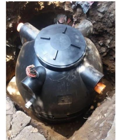
Imagen 133: Instalación de eco digestor. Fuente: oficina de proyecto, INC.
