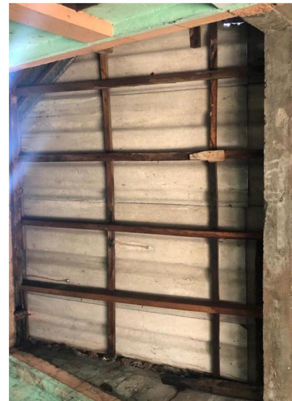
Imagen 110: Estructura de techo en garaje. Fuente: propia.
