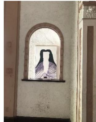
Imagen 161: Vano de arco de medio punto, pared oeste de sala 2. Fuente: propia.
