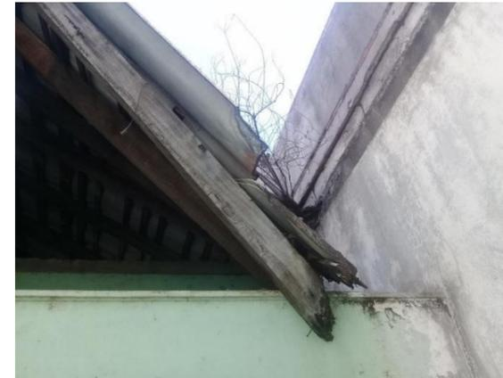
Imagen 125: Cubierta de techo colapsada en área de servicios sanitarios de piscina. Fuente: propia.
