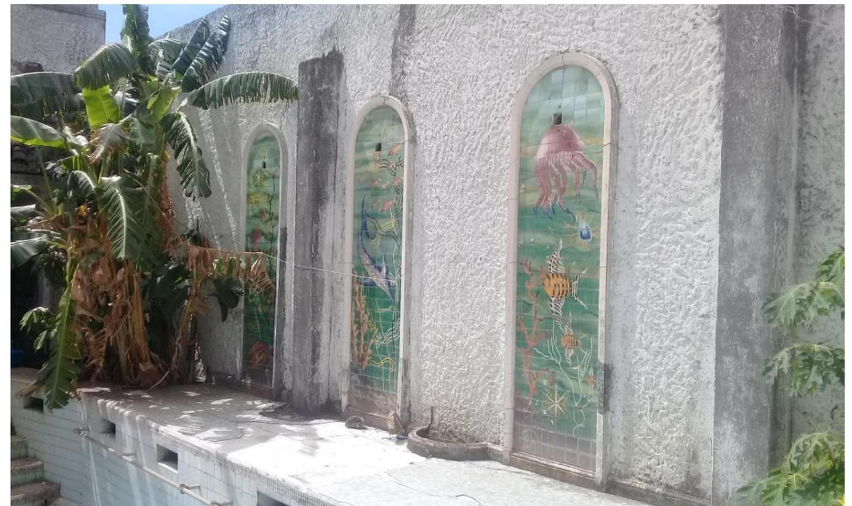
Imagen 98: Columnas de reforzamiento en pared. Fuente: propia.
