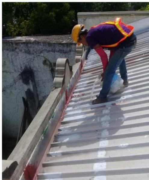
Imagen 124: Personal de obra realizando pruebas en canales. Fuente: oficina de proyecto, INC.
