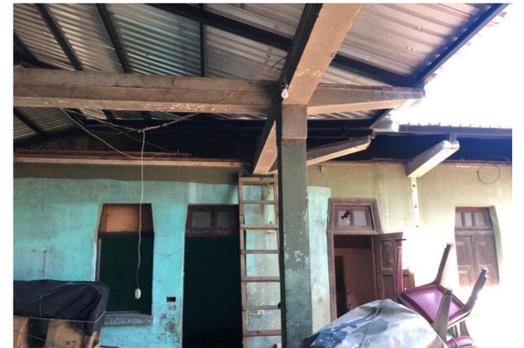
Imagen 97: Columnas de reforzamiento en pared. Fuente: propia.
