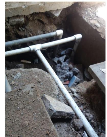
Imagen 135: Instalación de nueva tubería. Fuente: oficina de proyecto, INC.
