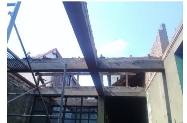
Imagen 128: Estructura y cubierta de techo desinstalada. Fuente: oficina de proyecto, INC.
