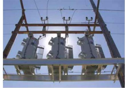
Figura 12 Montaje de Reguladores en plataforma aérea
