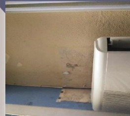
09 C FILTRACIÓN POR HUMEDAD, ENSUCIAMIENTO POR DEPÓSITO
