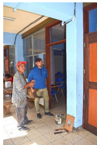
Fotografía 14: Br. Mejía realizando supervisión a instalación de puertas del edificio 15 (FARQ) y brindando asistencia a obreros.
