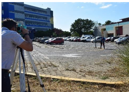
Fotografía 6: Levantamiento altiplanimétrico del estacionamiento (barrido de niveles) por parte de ambos bachilleres.
