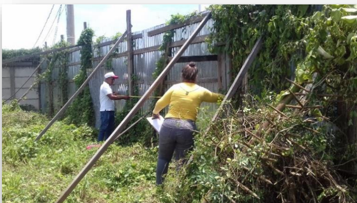
Ilustración 54. Mediciones del perímetro Fuente: Propia
