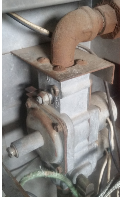
Fig.81 Electro-válvula del soplete y el piloto en un solo dispositivo.
