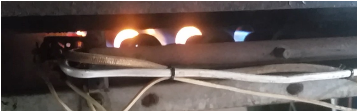
Fig.87 Soplete del horno a gas en funcionamiento, se puede ver la tubería de gas del piloto y el soplete.
