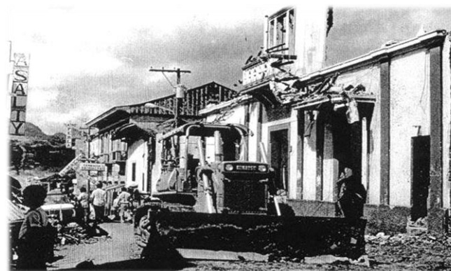
Ilustración 11 Demolición de tienda de Hernán Delgado para construir la Policía.
