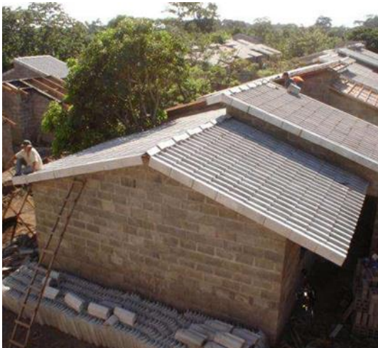
Foto 9: Construcción de viviendas utilizando techo de teja de micro concreto - Fuente: SofoNic
