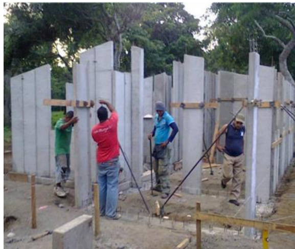
Foto 8: Construcción de vivienda utilizando teja de micro concreto y paneles de losa prefabricadas de Ferrocemento - Fuente: SofoNic
