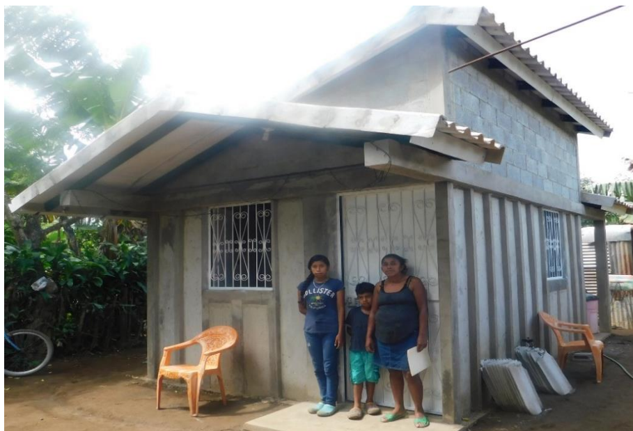
Foto 7: 2019 Mirazul del Llano – Nicaragua, Núcleo de paneles de ferrocemento – Fuente: SofoNic
