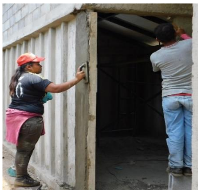
Foto 10: Mirazul del Llano – Nicaragua, Grupo vigente de Educación Dual en Construcción de vivienda - Fuente: SofoNic
