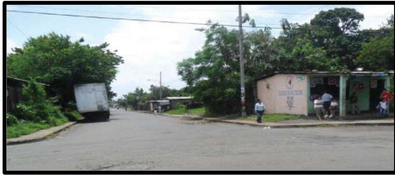
Ilustración 89. Segundo Acceso Principal, Pista Sabana Grande, en Buen Estado.
