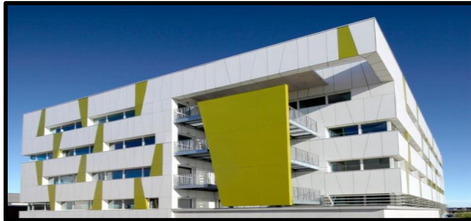
Ilustración 18. Fachada Edificio de Oficina_Pauta.
