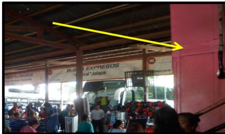
Ilustración 61. Forro Interno de Paredes.
