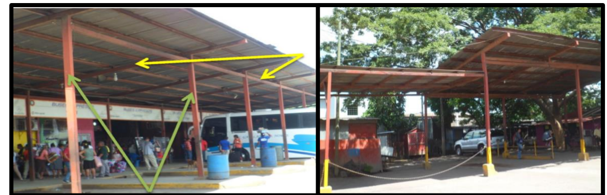
Ilustración 63. Estructura de Techo - Alero y Área de descenso.
