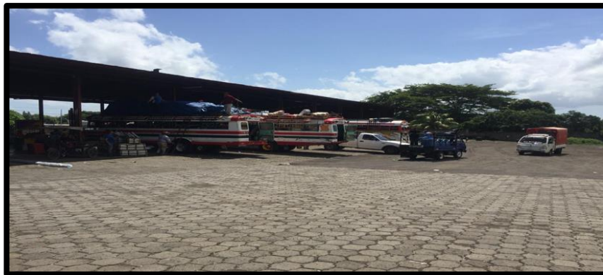
Ilustración 78. Vista de la Terminal Costa Caribe.
