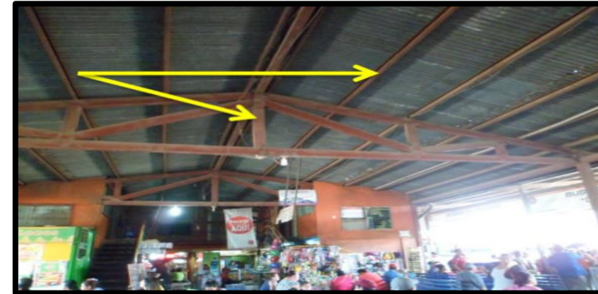
Ilustración 62. Estructura de Techo.
