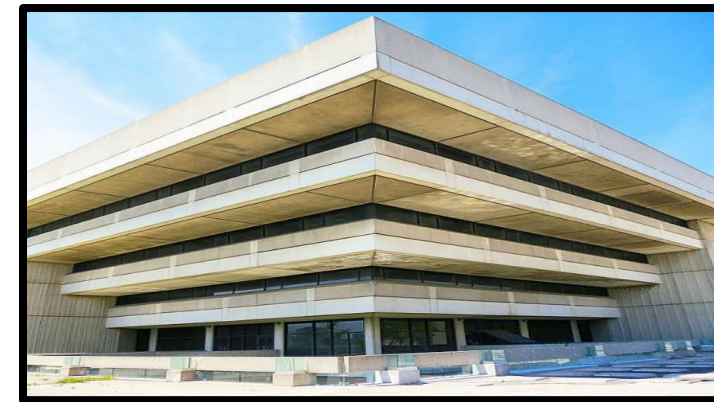
Ilustración 20. Fachada Edificio de Oficina.
