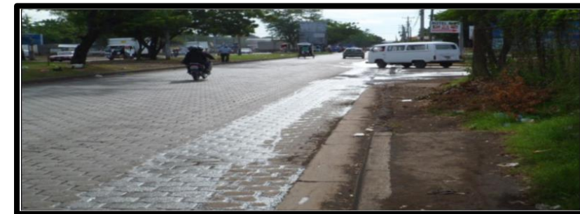
Ilustración 92. Pista el Mayoreo, Construida con Adoquines de Concreto.
