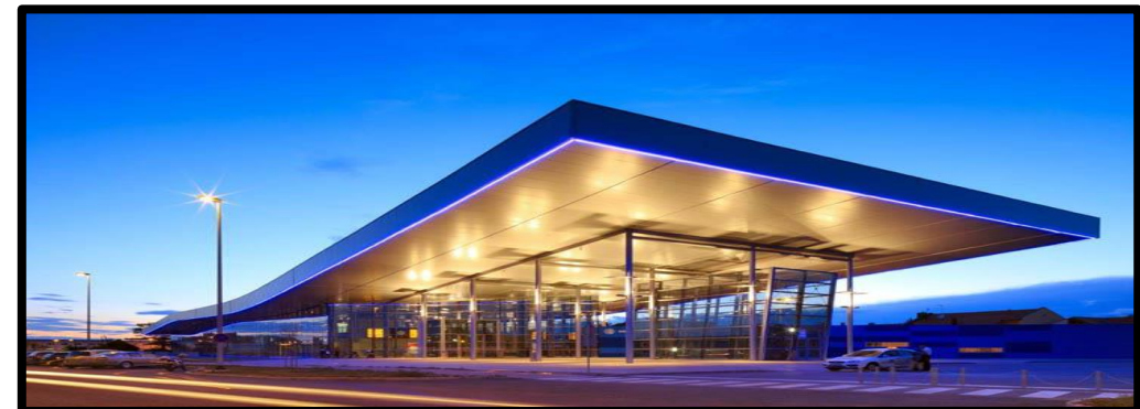
Ilustración 7. Terminal de Osijek.
