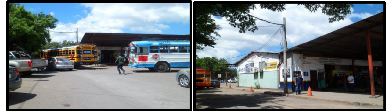
Ilustración 57. Circulación Obstaculizada, Ancho de Circulación en el Costado Sur del Edificio.
