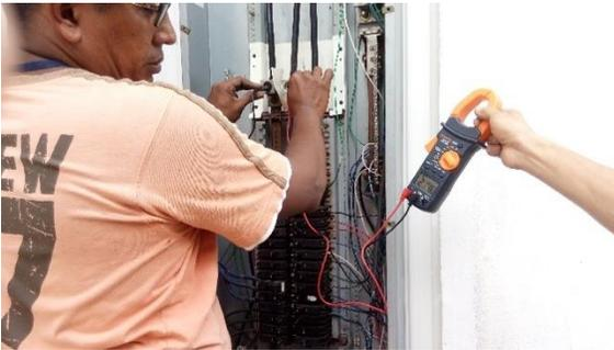
FOTO 36. INSPECCIÓN DE VOLTAJE Y AMPERAJE DE MAIN C.U.C.
