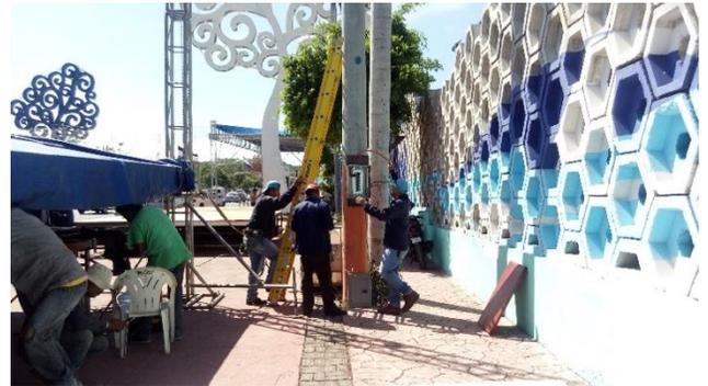
FOTO 188. INSTALACIÓN DE PANEL PARA LÍNEAS DE ALIMENTACIÓN ELÉCTRICA DE TARIMA
