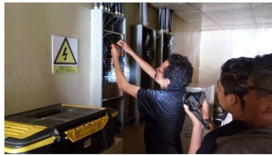
FOTO 122. INSPECCIÓN DE FUNCIONAMIENTO DE MAIN BREAKERS
