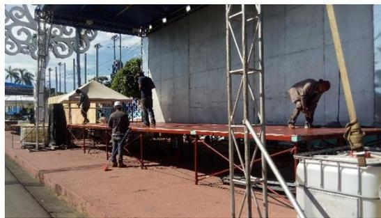
FOTO 199. INSPECCIÓN NIVELACIÓN DE TARIMA, LÁMINAS DE PLYWOOD DE RECUBRIMIENTO
