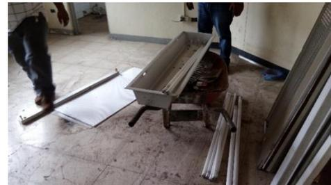
FOTO 166. DESINSTALACIÓN DE LÁMPARAS Y CAJAS EMPOTRADAS EN TELEFONIA
