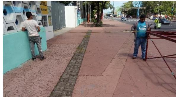
FOTO 184. MEDICIÓN DE PUNTOS PARA INSTALACIÓN DE ESTRUCTURA DE TARIMA
