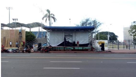
FOTO 195. TENSADO DE BACKGROUND LONA VINÍLICA DE 12.5M X 4.8M
