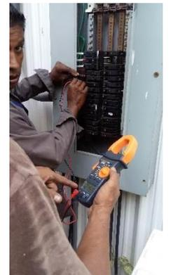
FOTO 45. INSPECCION DE AMPERAJE Y VOLTAJE
