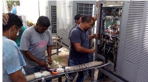
FOTO 39. INSPECCIÓN DE CONDENSADORAS Y AIRES ACONDICIONADOS C.U.C.
