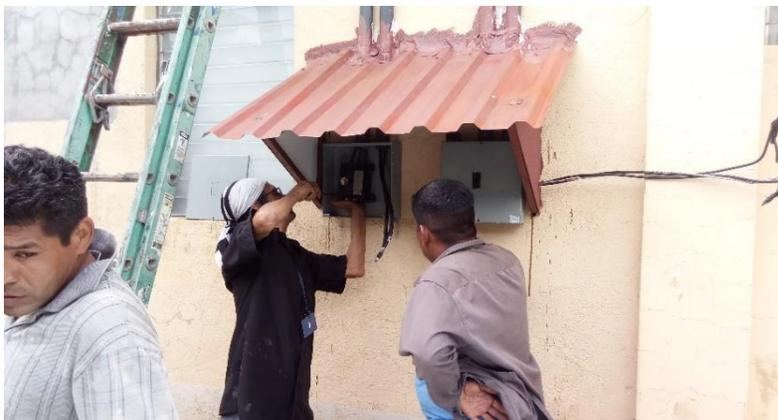
FOTO 91. INSPECCIÓN CAMBIO DE MAIN BREAKER NORMAS DE LA CONSTRUCCIÓN
