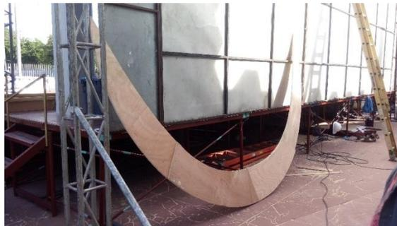
**FOTO 260. LUNA ORNAMENTAL DE PLYWOOD LISTA PARA SU CUBIERTA DE VINIL ADHESIVO PLATEADO**
