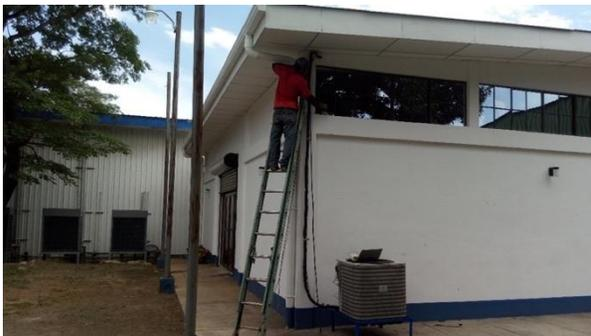
FOTO 11. ACOMETIDAS DE CONDENSADORAS
