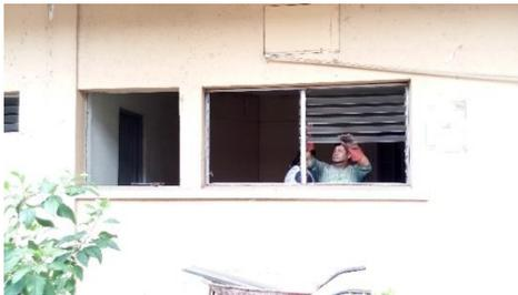
FOTO 165. DESINSTALACIÓN DE VENTANAS Y MARCOS DE VENTANAS DE TELEFONIA
