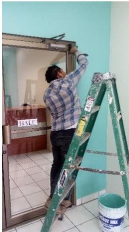
FOTO 62. REPARACION DE BRAZO MECANICO PUERTA ABATIBLE
