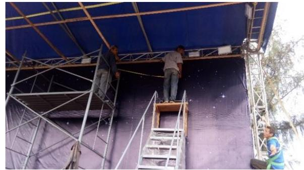
FOTO 207. ARMADO DE ESTRUCTURA TENSORA DE CIELO FALSO, REVISIÓN DE REFLECTORES
