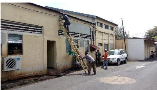
FOTO 119. INSTALACIÓN DE LÍNEA DE ALIMENTACIÓN ELÉCTRICA PARA ACOMETIDAS
