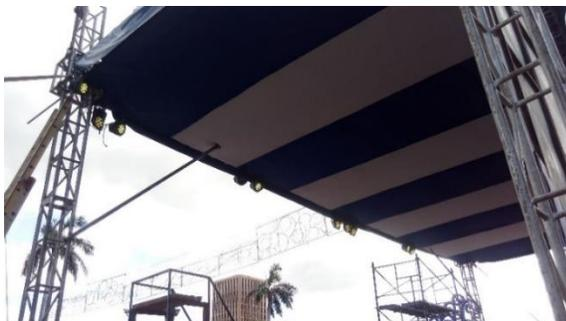
FOTO 212. INSTALACIÓN DE REFLECTORES COLOR BLANCO CÁLIDO PARA PARTE SUPERIOR DE LA TARIMA
