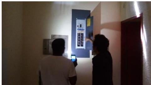
FOTO 163. DESINSTALACIÓN DE MAIN BREAKERS
