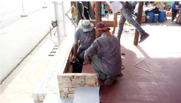
FOTO 209. INSTALACION DE COLUMNAS DE MADERA ROLLIZA PARA CHOZA
