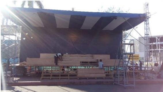
FOTO 214. FORRADO CON LÁMINAS DE PLYWOOD DE ESTRUCTURAS DE MADERA DE GRADERÍAS Y CAJONES DE JARDÍN
