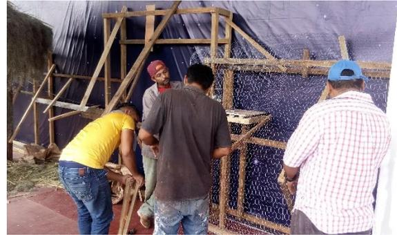
FOTO 220. BASE PARA MASETERAS DENTRO DE ROCA ARTIFICIAL
