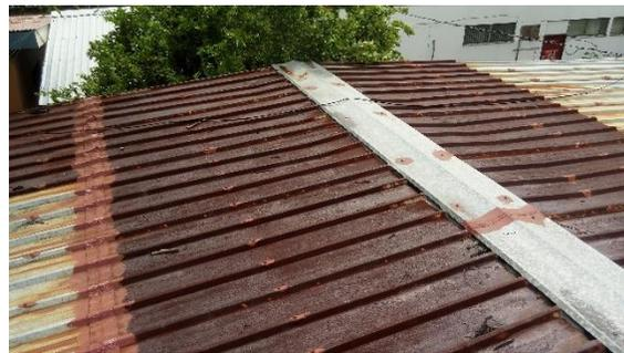
FOTO 94. LOCALIZACIÓN DE FILTRACIONES DE AGUA EN CUBIERTA DE TECHO D.G.T.T.
