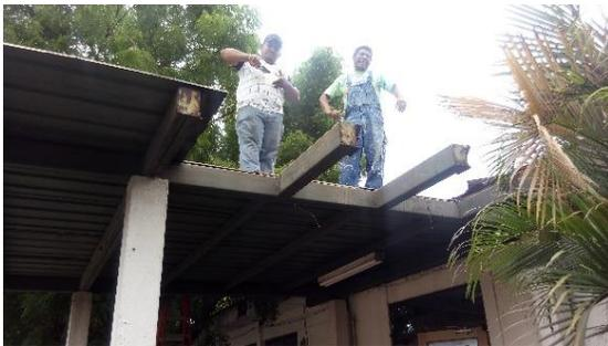
FOTO 71. INSPECCION DE ESTADO DE CUBIERTA DE TECHO RETIRO DE LAMINAS
