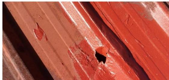
FOTO 96. DAÑO CONSIDERABLE A CUBIERTA DE TECHO SE PROPONE CAMBIO DE LÁMINAS D.G.T.T.
