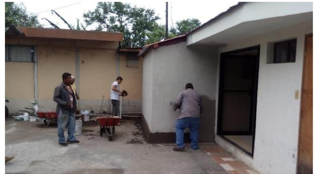
FOTO 158. ACABADOS DE PAREDES CON REPELLO
