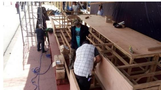
FOTO 211. ARMADO DE GRADERÍAS, BASE DEL ALTAR Y CERRAMIENTO DE CAJONES DE JARDÍN
