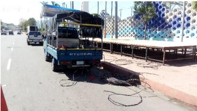
FOTO 191. DESMONTAJE DE LÍNEA DE CABLEADO ELÉCTRICO PARA ABASTECIMIENTO ENERGÉTICO DE TARIMA
