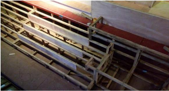
FOTO 251. CERRAMIENTO DE GRADERÍAS PARA SU POSTERIOR RECUBRIMIENTO CON VINIL ADHESIVO
