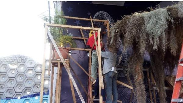
FOTO 221. DISTRIBUCION DE MALLA PARA ARMADO DE ROCA ARTIFICIAL
