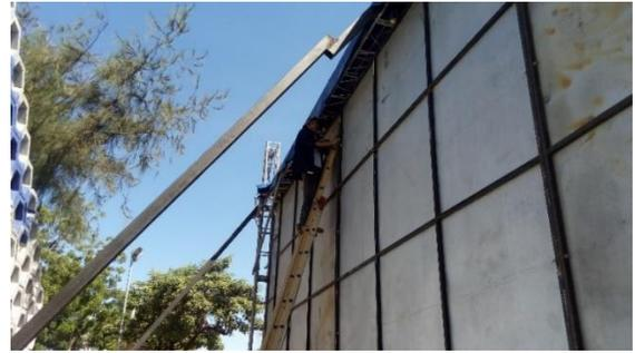
**FOTO 256. REFUERZOS DE PERLINES PARA CONTRAFUERTE DE ESTRUCTURA DE TECHO DE TARIMA**
