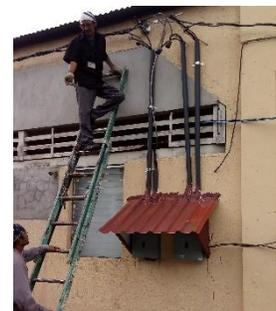
FOTO 92. DESINSTALACIÓN DE ALIMENTACIÓN ELÉCTRICA HACIA PANELES
