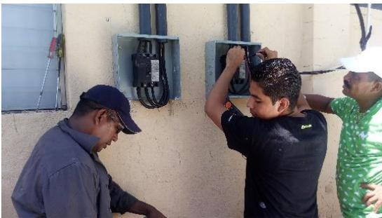
FOTO 121. INSPECCIÓN DE ACOMETIDAS ELÉCTRICAS Y PANELES
