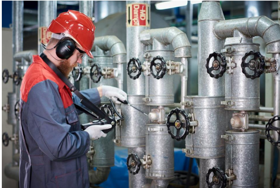
Figura. 8 Detección de fugas de presión o vacío por medio del ultrasonido Fuente extraída de: https://www.uesystems.com/
