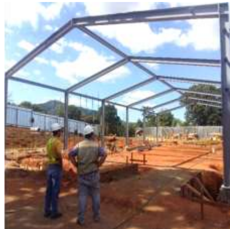
Imagen 51 Fijación de marcos metálico.
