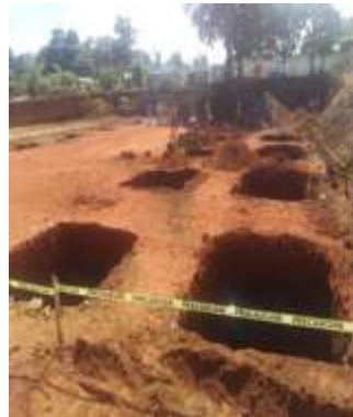
Imagen 45 Excavación de viga de fundación y mejoramiento de suelo
