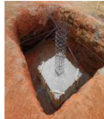
Imagen 46 Zapatas fundidas
