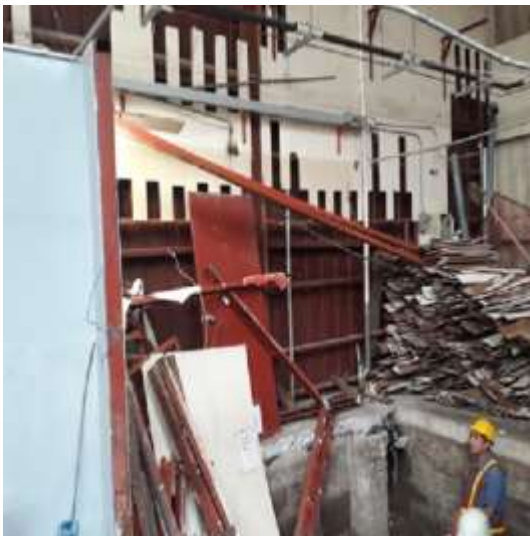
Imagen 133 Demolición de losa de área de soda y cuarto de bombas existentes Fuente Elaboración Propia.
