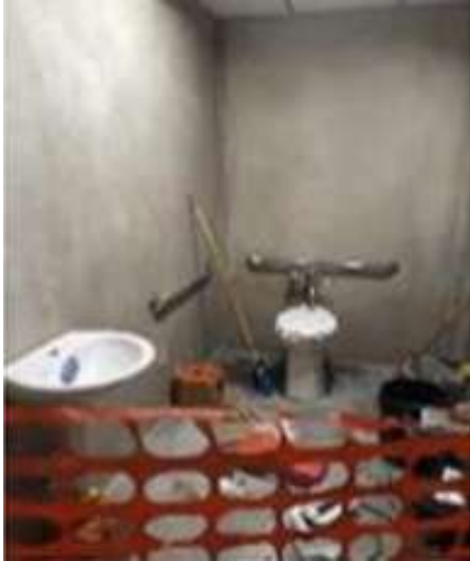
Imagen 127 .Baño de asociados colocación de azulejos e instalación de equipos higiénicos. Fuente propia.
