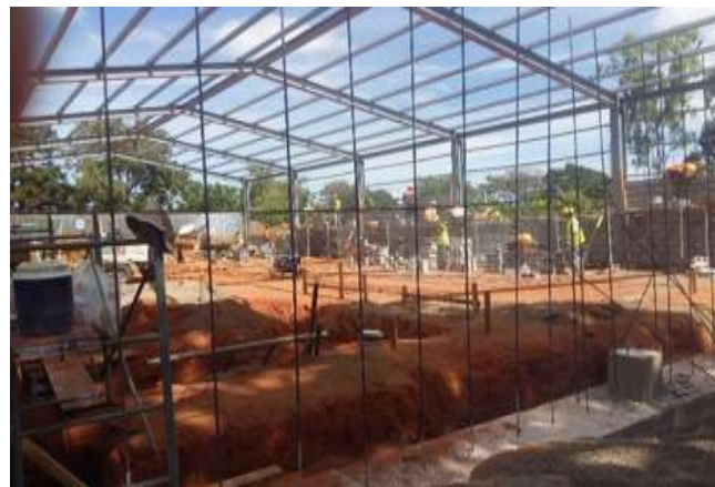
Imagen 52 Colocación de mampostería y refuerzo. Fuente: Elaboración propia
