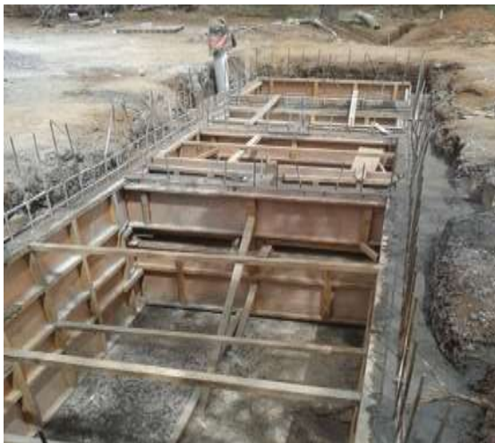
Imagen 29 Supervisión de Rehabilitación del Hospital Primario de Nandaime, MINSA, Mayo 2014- Septiembre 2014. Fuente: JHM Arquitectos
