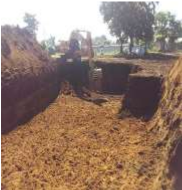
Imagen 44 Excavación de zapatas
