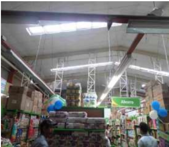
Imagen 137 Vista del edificio interna antes de la remodelación. Fuente Elaboración Propia.
