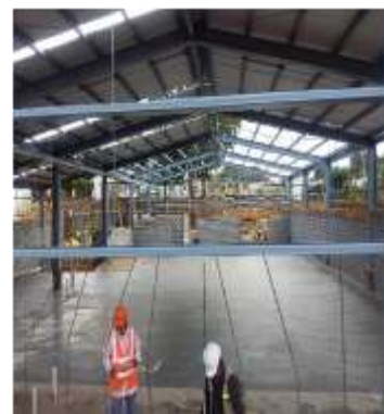
Imagen 55 Acabado y curado de piso
