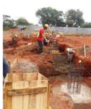
Imagen 48 Colocación de acero y colado de vigas
