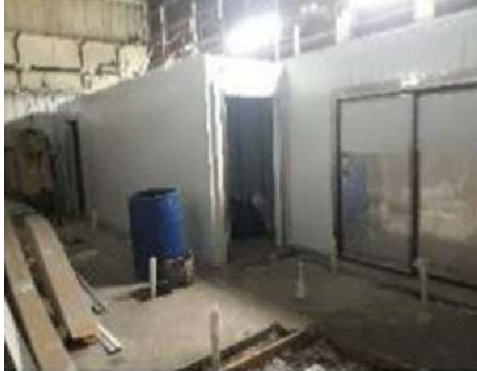
Imagen 128. Instalación de paneles de cuartos fríos. Fuente propia.
