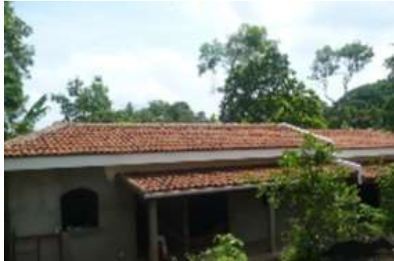
Imagen 7 Construcción de vivienda de Sandra Ramos. Fuente: JHM Arquitectos.
