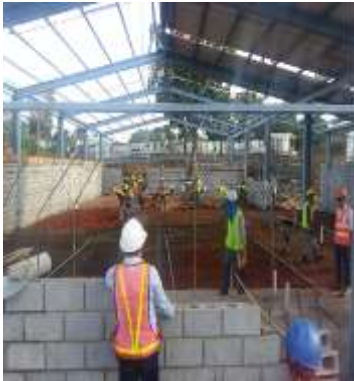
Imagen 53 Nivelación de terraza en área de tienda
