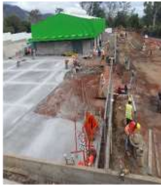
Imagen 66 Colada de concreto de zona de parqueo.
