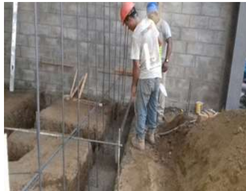
Imagen 87 Llenado de concreto en vigas de fundación área de soda Fuente propia.
