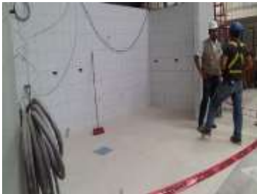
Imagen 94 Proceso de colocación de textura en piso de áreas de proceso. Fuente propia.
