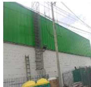
Imagen 105 Pintura de fachada Oeste principal. Fuente propia.
