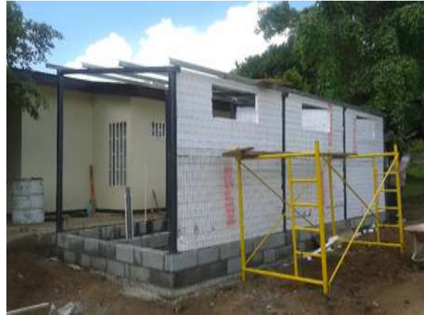
Imagen 28 Construcción de baños y vestidores para trabajadores en DIKAMAR S.A., Pista el Mayoreo, Managua, Fuente: JHM Arquitectos
