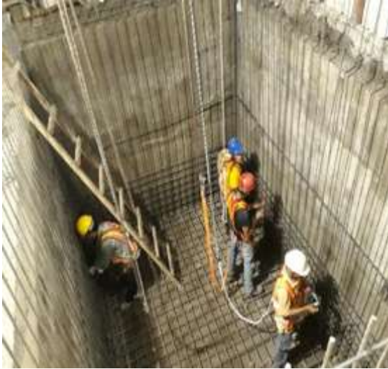
Imagen 135 colocación de acero de refuerzos para cisterna.
