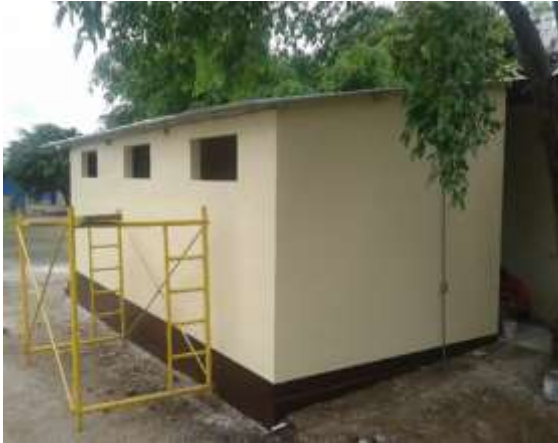
Imagen 27 Construcción de baños y vestidores para trabajadores en DIKAMAR S.A., Pista el Mayoreo, Managua, Fuente: JHM Arquitectos
