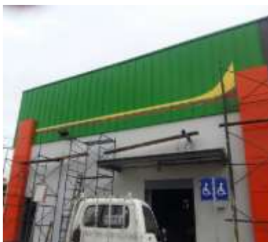
Imagen 103 pintura de fachada principal Fuente propia.
