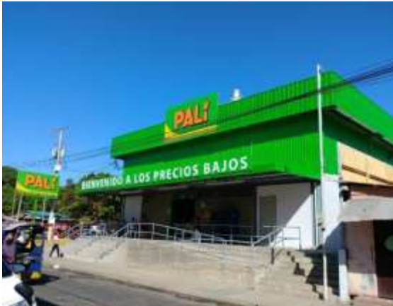
Imagen 18 Supervisión de Construcción de Pali TICUANTEPE, Managua. Fuente: JHM Arquitectos
