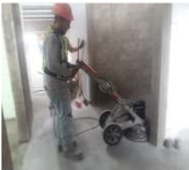
Imagen 97 Pulido en pisos de área de soda. Fuente propia.
