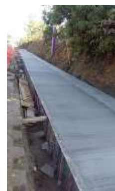
Imagen 70 Texturizado en anden de carril finalizado
