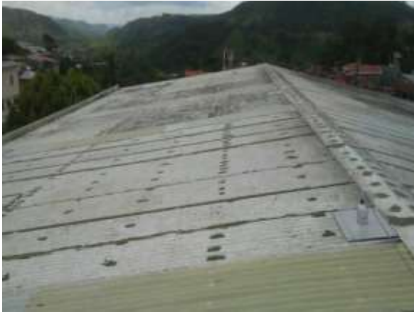
Imagen 139 Vista de techo existente Fuente Elaboración Propia.
