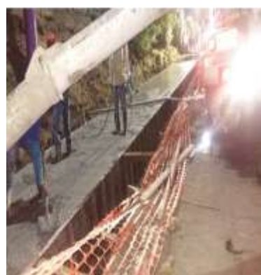
Imagen 69 Colada de concreto de carril de desaceleración
