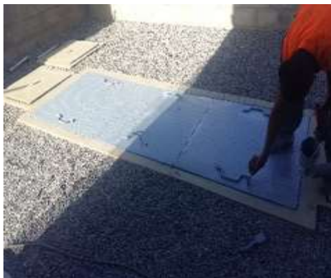
Imagen 74 Cajas de registro sanitarias, y trampa de grasa finalizada
