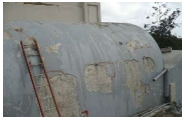
Imagen 9 Restauración, Cúpulas de capilla, San Marcos, Carazo. Fuente: JHM Arquitectos
