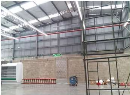
Imagen 106 Instalación de red interna de SCI Fuente propia. Fuente propia.
