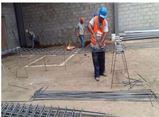
Imagen 86 Armado de zapatas para áreas de oficinas, trastienda, áreas de proceso y soda. Fuente propia.
