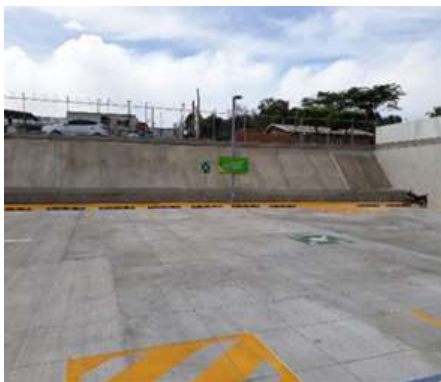
Imagen 62 Recubrimiento de talud y cerramiento norte.
