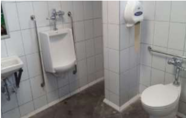
Imagen 110 Baño de asociados colocación de azulejos e instalación de equipos higiénicos. Fuente propia.
