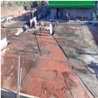
Imagen 65 Conformación y compactación de terreno final.
