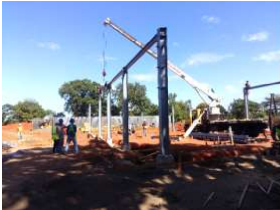
Imagen 50 Colocación de columnas metálicas
