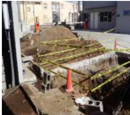
Imagen 92 Excavación de trampa de grasa. Fuente propia.
