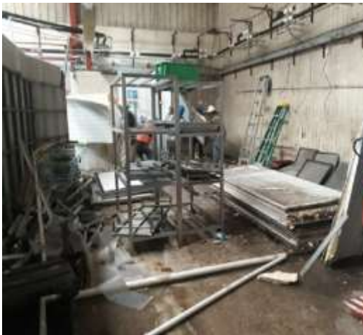
Imagen 129 .Demolición de área de carnicería y cuartos fríos. Fuente propia.
