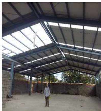
Imagen 57 Vistas del proceso de colocación de láminas de techo.
