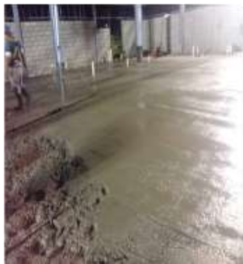
Imagen 54 Acabado y curado de piso
