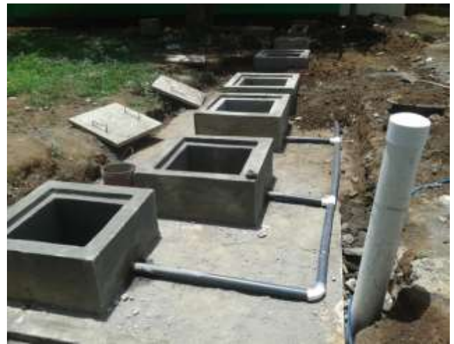
Imagen 30 Supervisión de Rehabilitación del Hospital Primario de Nandaime, MINSA, Mayo 2014- Septiembre 2014. Fuente: JHM Arquitectos
