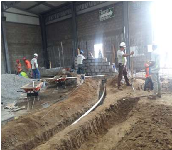
Imagen 112 Excavación y acometida de tubería PVC. Fuente propia.
