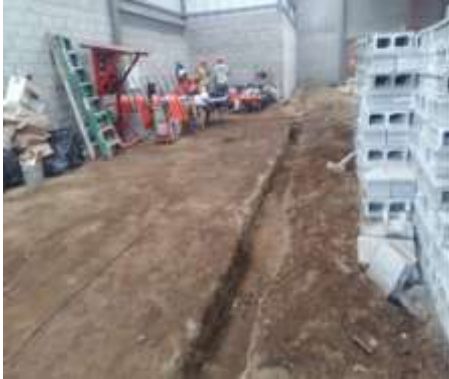
Imagen 84 Excavaciones en área de bodega Fuente propia.
