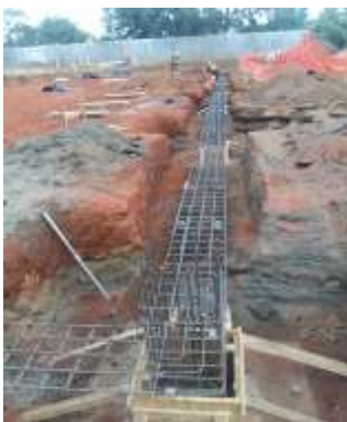
Imagen 47 Colocación de acero y colado de vigas
