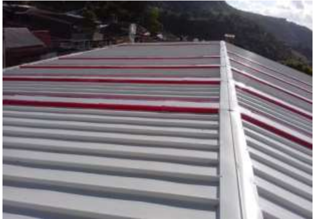
Imagen 140 Cambio de cubierta de tienda Fuente Elaboración Propia.
