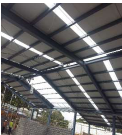
Imagen 56 Vistas del proceso de colocación de láminas de techo
