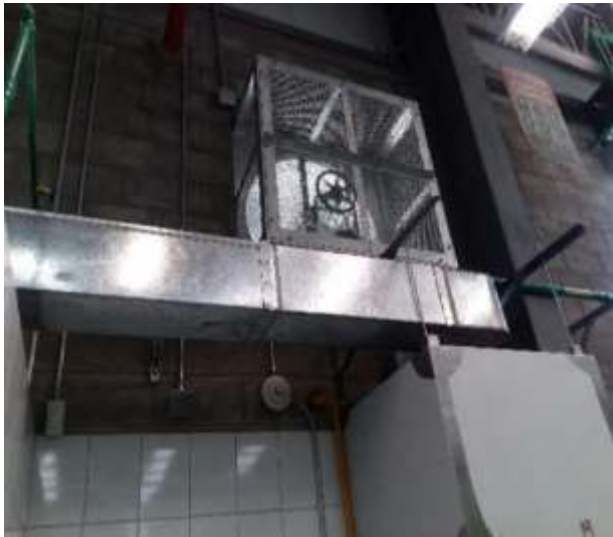
Imagen 117 Instalación de extractores parte interna Fuente propia.
