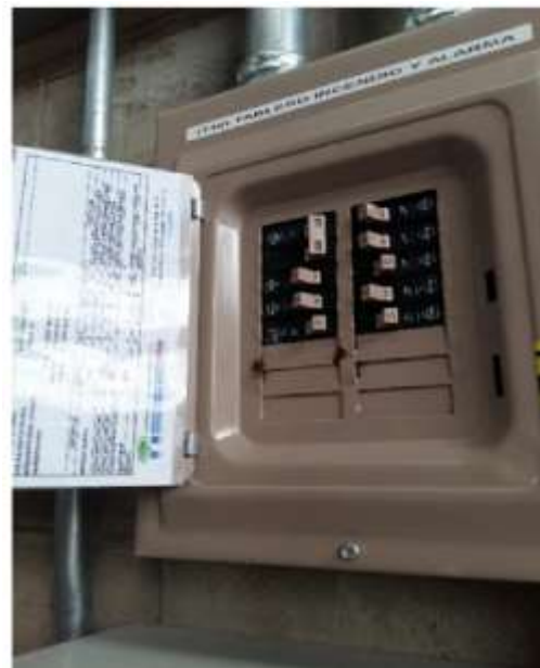
Imagen 109 Rotulación de paneles eléctrico finalizado. Fuente propia.
