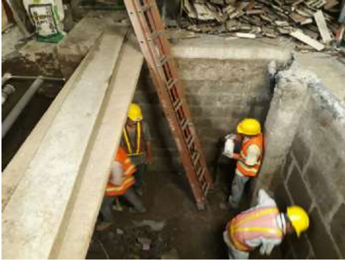
Imagen 131 Excavación de cisterna Fuente Elaboración Propia.
