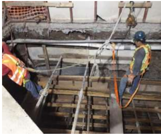
Imagen 136 Colado de cisterna.
