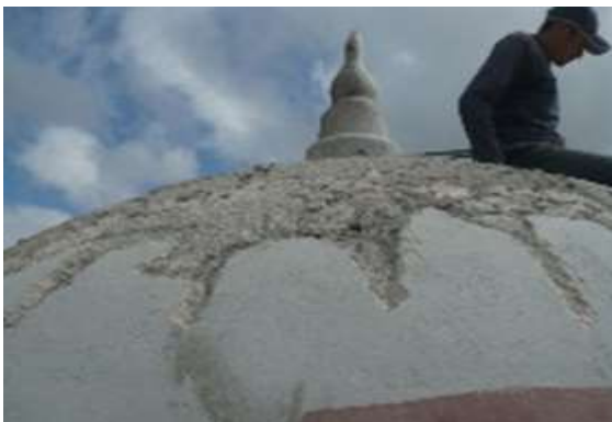
Imagen 8 Restauración, Cúpulas de capilla, San Marcos, Carazo. Fuente: JHM Arquitectos
