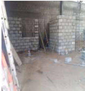
Imagen 89 Colocación de mampostería en admón. Fuente propia.
