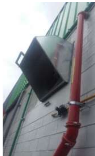
Imagen 118 Instalación de extractores parte interna Fuente propia.
