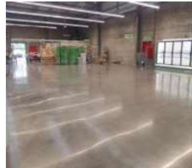
Imagen 99 Acabado del piso de tienda. Fuente propia.
