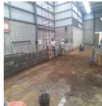
Imagen 90 Colocación de mampostería en bodega . Fuente propia.
