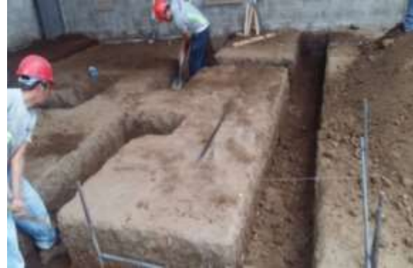
Imagen 85 Excavaciones en área de Oficinas Fuente propia.
