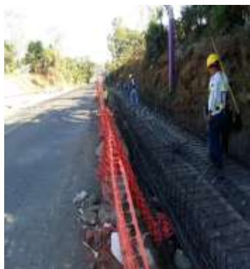
Imagen 68 Armado de acero de cajas puentes
