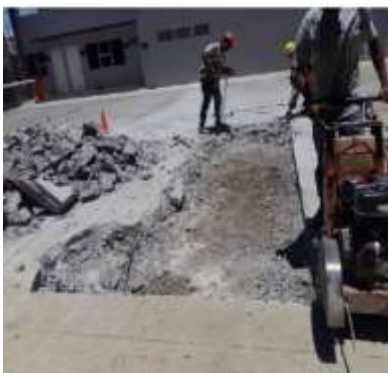
Imagen 91 Demolición de área de trampa de grasa. Fuente propia.
