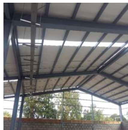
Imagen 58 Vistas del proceso de colocación de láminas de techo.
