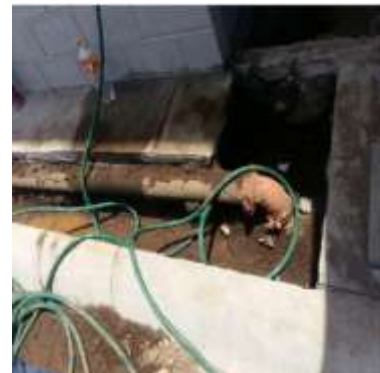
Imagen 93 Ruptura de anden para cometida Tubería de drenaje. Fuente propia.
