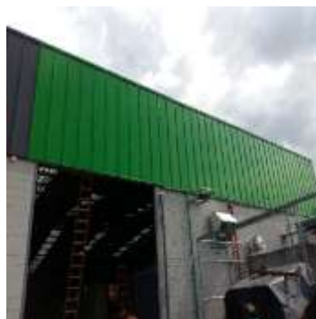
Imagen 104 Pintura de fachada Norte principal Fuente propia.
