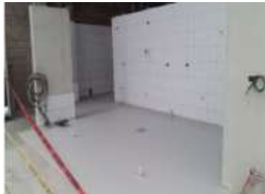
Imagen 95 Proceso de colocación de textura en piso de áreas de proceso. Fuente propia.
