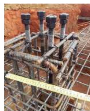
Imagen 49 Colocación de pernos en pedestal
