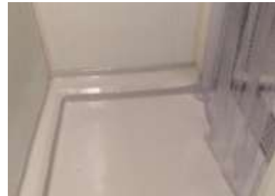
Imagen 96 Proceso de colocación de textura en piso de áreas de cuartos fríos. Fuente propia.
