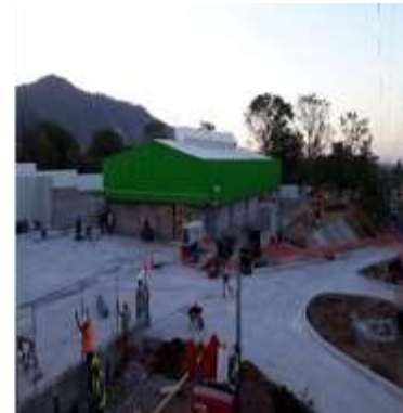
Imagen 67 Colada de concreto de Rodamiento y acceso a la tienda
