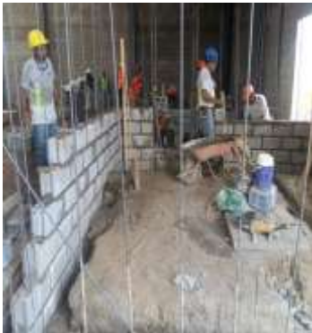
Imagen 88 Colocación de mampostería en soda Fuente propia.
