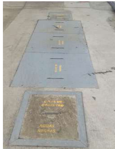
Imagen 113 Trampa de grasa finalizada con tapas metálicas y señalización Fuente propia.
