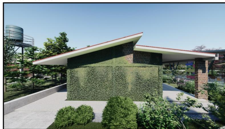
Ilustración 139 Alero largo para la protección del sol y lluvia fachada oeste de pabellón de aula de secundaria. Fuente: Autores.
