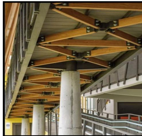
Ilustración 48 Estructura de madera y pilares de concreto. Fuente: <https://www.nortesurararquitectos.com/escuelasectorangeles>
