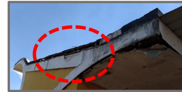
Foto No. 23. Desprendimiento de fascia en sección de cubierta de techo de Servicios Sanitarios y Tarima. Fuente: Autor.
