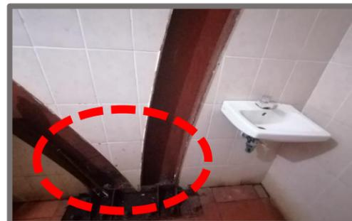
Foto No. 20. Exposición de estructura metálica en sección de pared de servicios sanitarios. Fuente: Autor.
