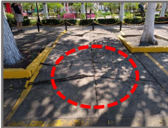
Foto No. 18. Desprendimiento en losa de concreto por raíces de árboles en área de estacionamiento. Fuente: Autor.
