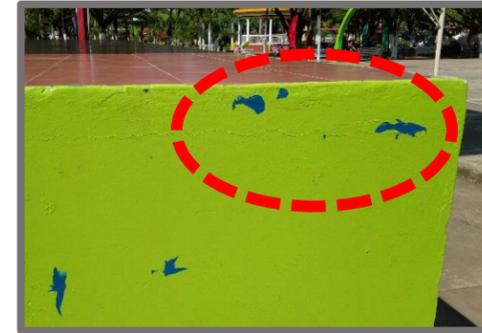
Foto No. 22. Desprendimiento de pintura en sección de plataforma de Tarima. Fuente: Autor.
