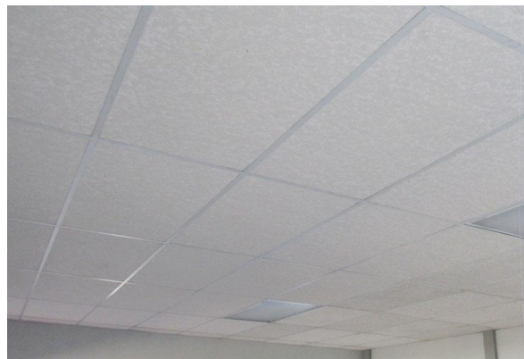
Ilustración N°29: Resultado final cielo falso
