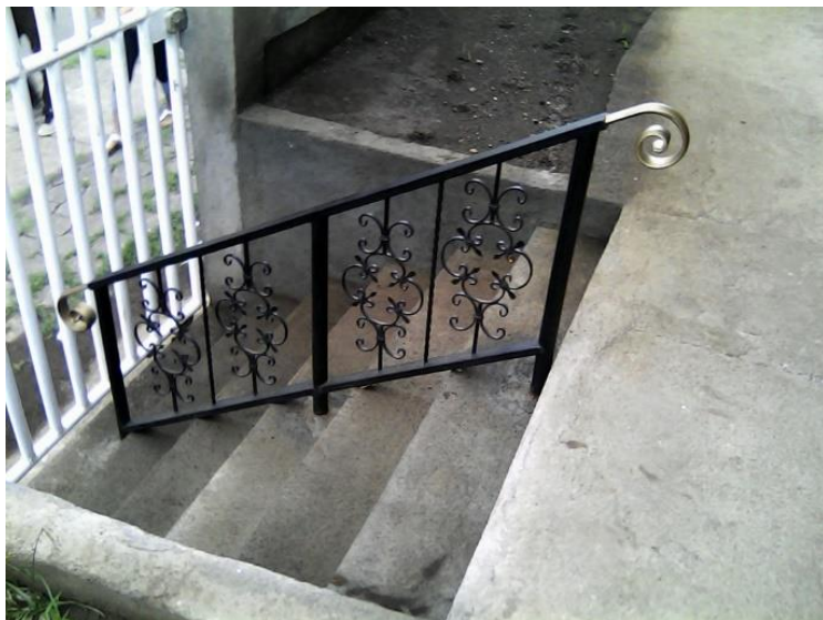
Ilustración N°8: Trabajo realizado -barandilla
