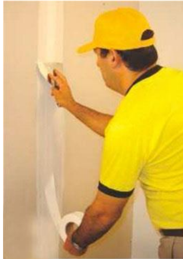
Ilustración N°24: Enmasillado.
