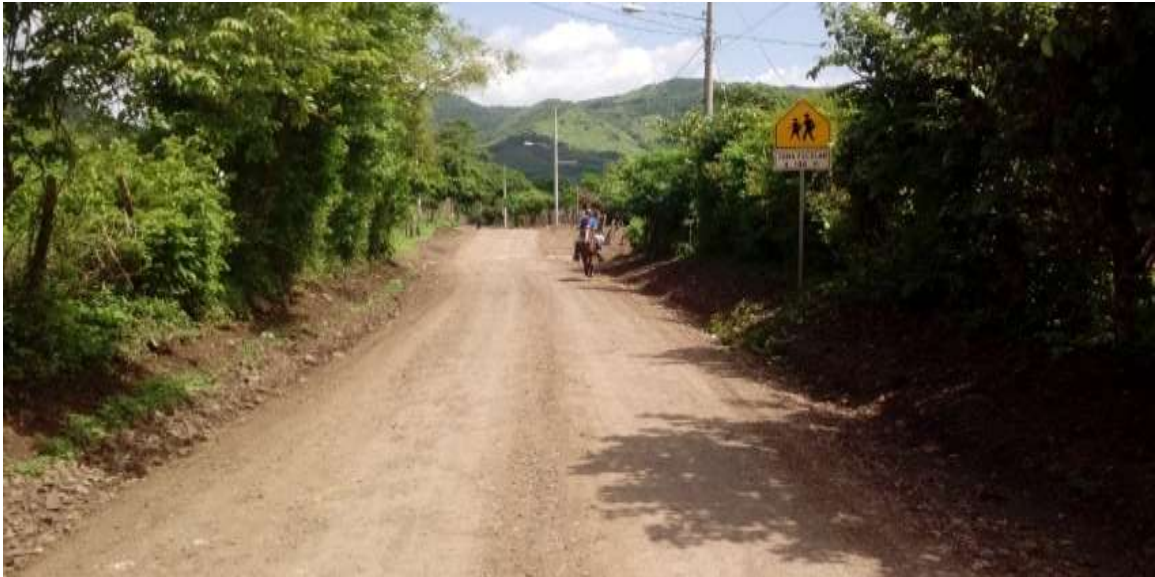
Imagen No. 32: Muestra el después de la actividad de Suministro e instalación de señal zona escolar a 100m en estación 104+655
