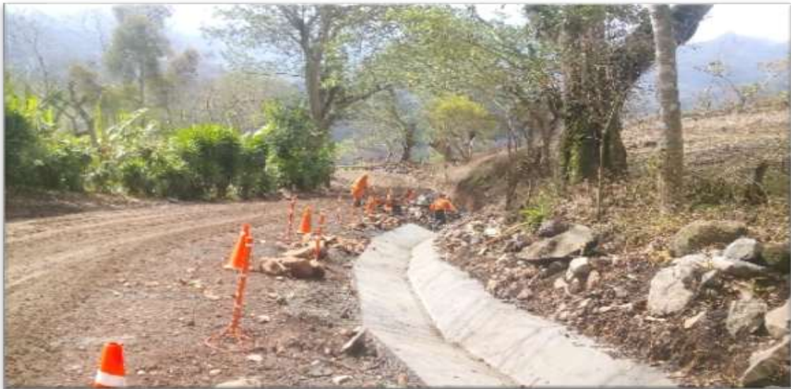
Imagen No.13: Muestra el durante de la actividad de Construcción de Cunetas Revestida con Mampostería en estación 122+650 a 122+772.10
