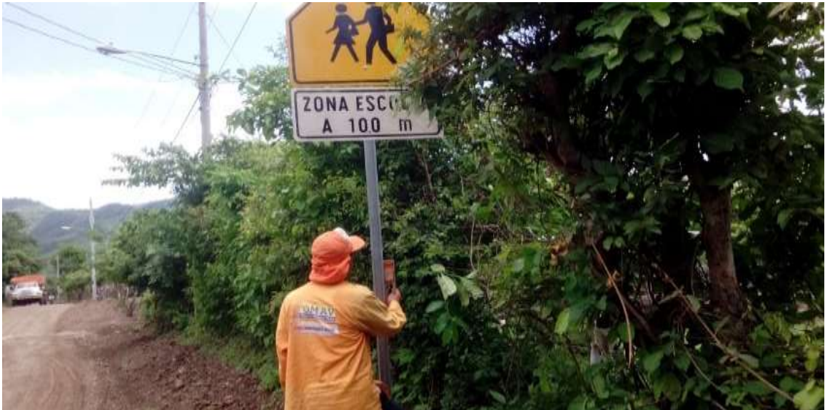
Imagen No. 31: Muestra el durante de la actividad de Suministro e instalación de señal zona escolar a 100m en estación 104+655
