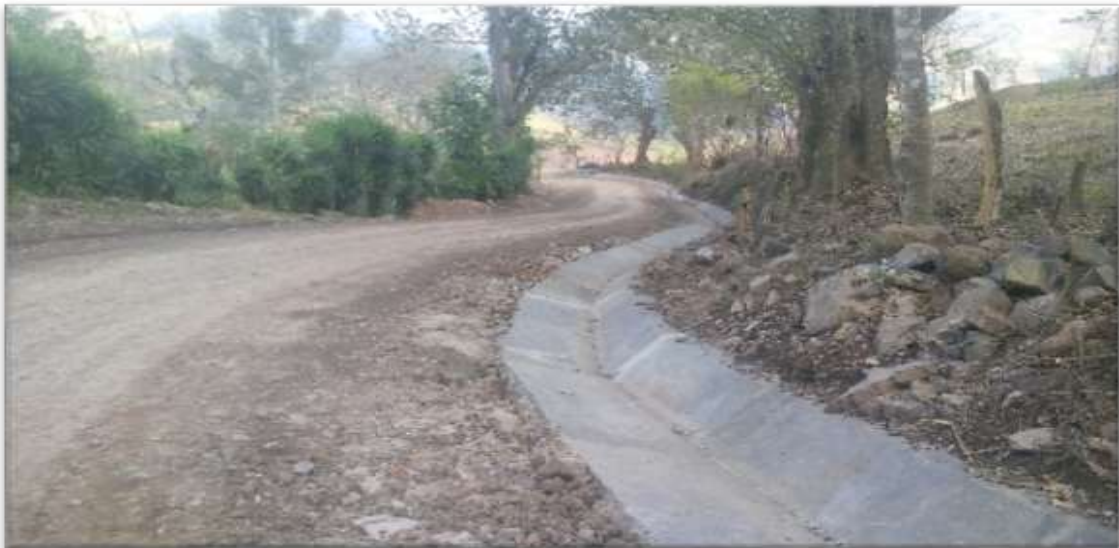
Imagen No. 14: Muestra el después de la actividad de Construcción de Cunetas Revestida con Mampostería en estación 122+650 a 122+772.10
