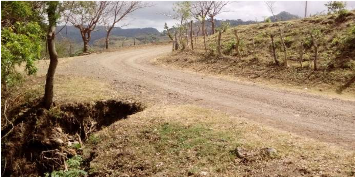
Imagen No. 21: Muestra el antes de la actividad de Relleno con Material Selecto en estación 114+776 a 114+800 B.I
