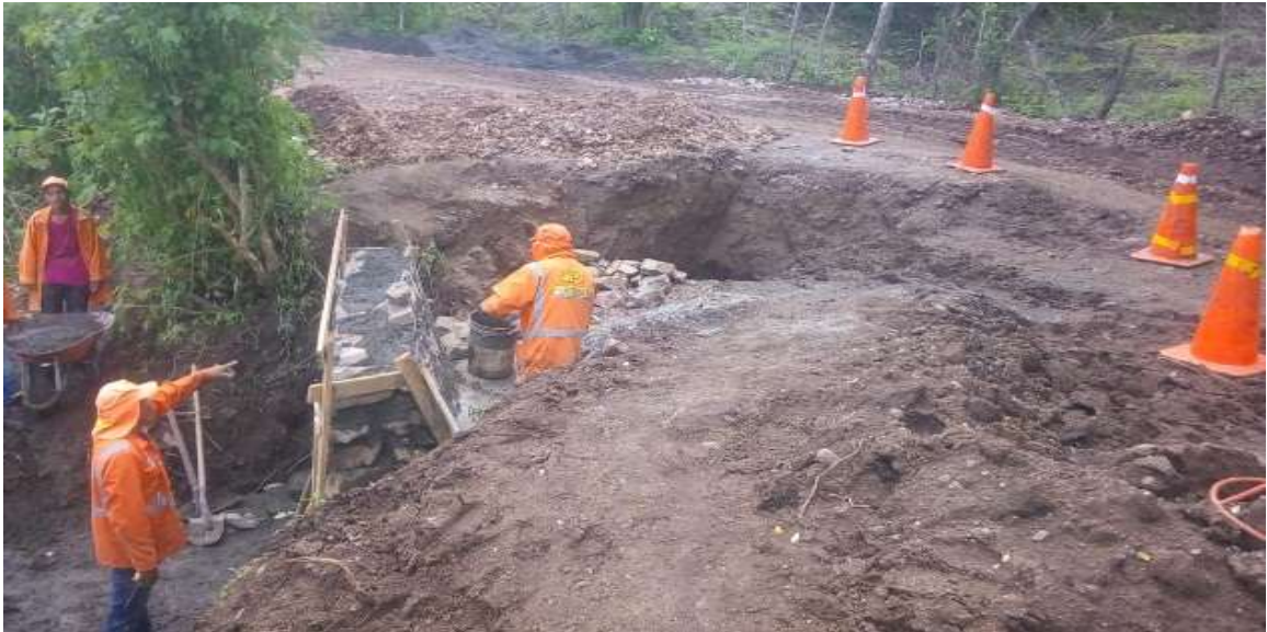
Imagen No. 16: Muestra el durante de la actividad de Mampostería en estación 114+776 a 114+800 B.I
