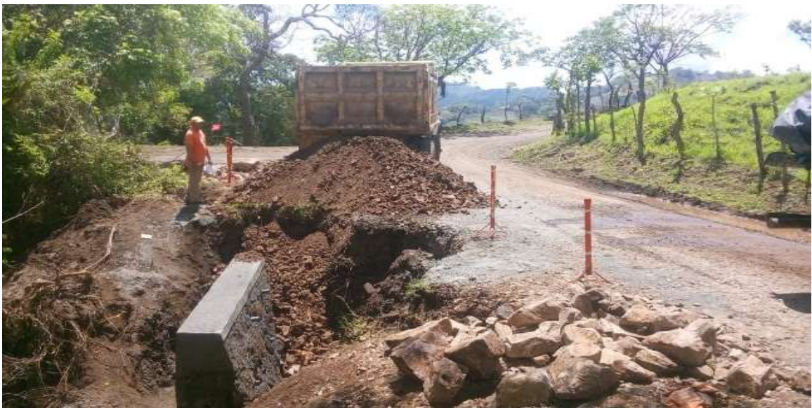
Imagen No. 22: Muestra el durante de la actividad de Relleno con Material Selecto en estación 114+776 a 114+800 B.I
