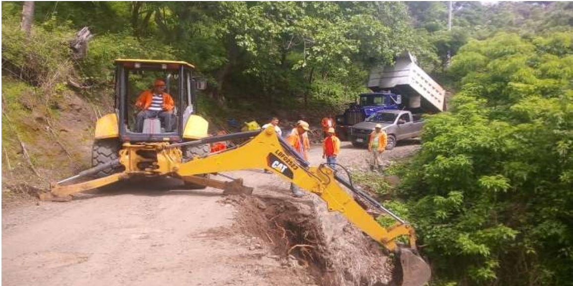
Imagen No. 19: Muestra el durante de la actividad de Excavación Estructural en estación 108+354 a 108+360.80, B.D
