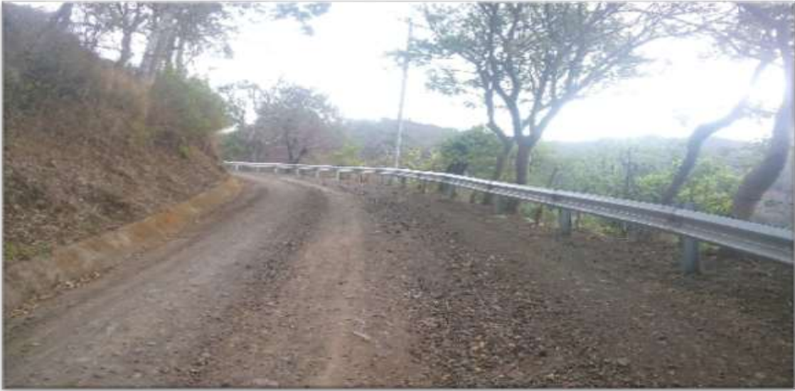
Imagen No.3: Muestra el antes en la actividad de Reposición de Capa Balasto en estación 112+975 a 113+075.
