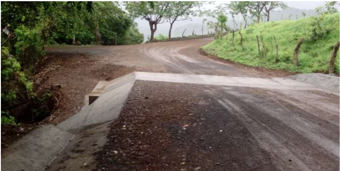
Imagen No. 17: Muestra el después de la actividad de Mampostería en estación 114+776 a 114+800 B.I
