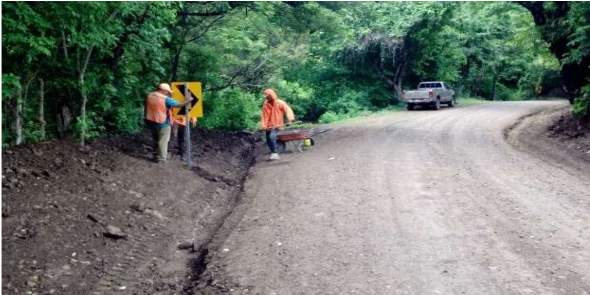
Imagen No. 28: Muestra el durante de la actividad de Suministro e instalación de chevrones en estación 105+755 a 105+835 B.I.
