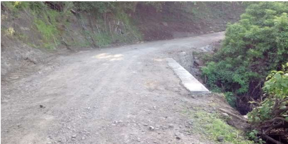
Imagen No. 20: Muestra el después de la actividad de Excavación Estructural en estación 108+354 a 108+360.80, B.D
