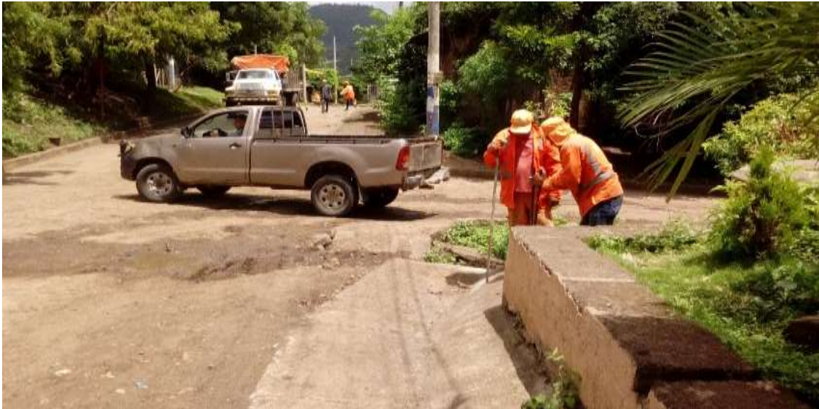
Imagen No. 36: Muestra el durante de la actividad de Suministro e instalación de señal cruce escolar en estación 104+985
