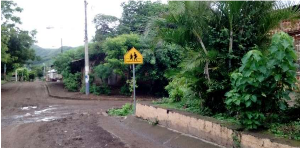
Imagen No. 37: Muestra el después de la actividad de Suministro e instalación de señal cruce escolar en estación 104+985
