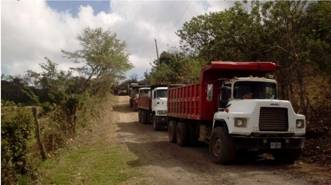
Imagen No. 25: Camiones en curso de actividad de Reposición de capa balasto.
