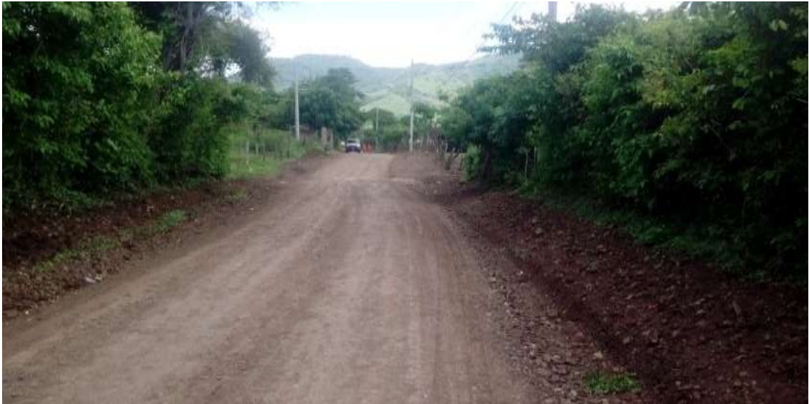
Imagen No. 30: Muestra el antes de la actividad de Suministro e instalación de señal zona escolar a 100m en estación 104+655
