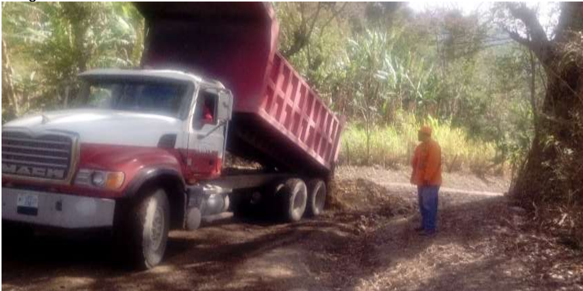
Imagen No. 26: Muestra colocación de material balasto en estación 122+650
