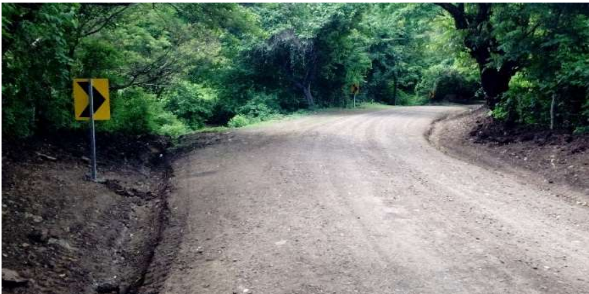
Imagen No. 29: Muestra el después de la actividad de Suministro e instalación de chevrones en estación 105+755 a 105+835 B.I.
