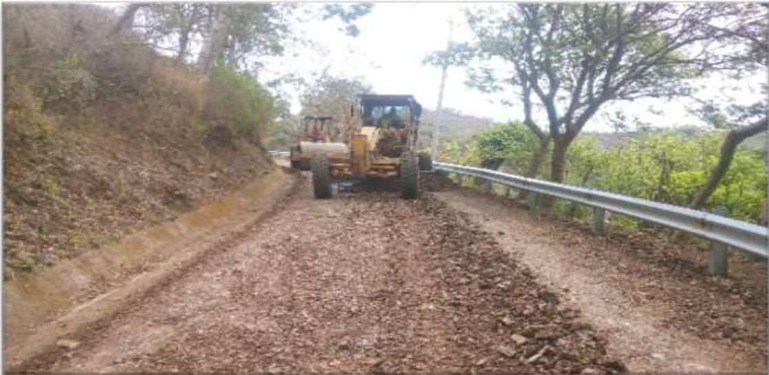
Imagen No.4: Muestra el durante en la actividad de Reposición de Capa Balasto en estación 112+975 a 113+075.
