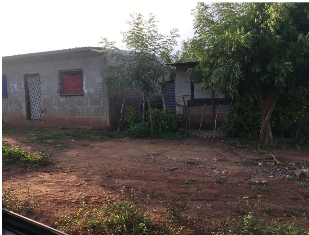
Figura 8. Estado de las viviendas
