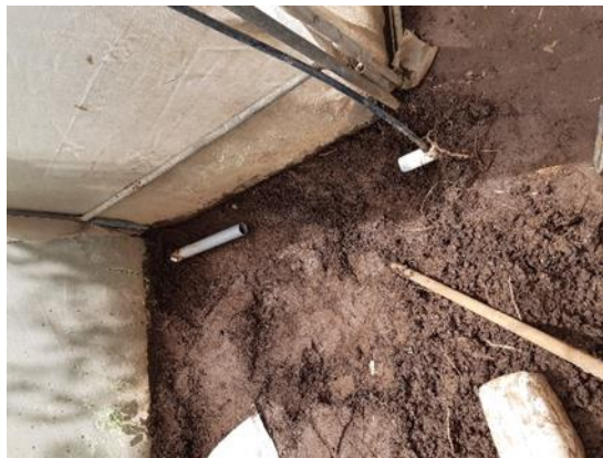
Figura 40. Instalando la electroválvula
