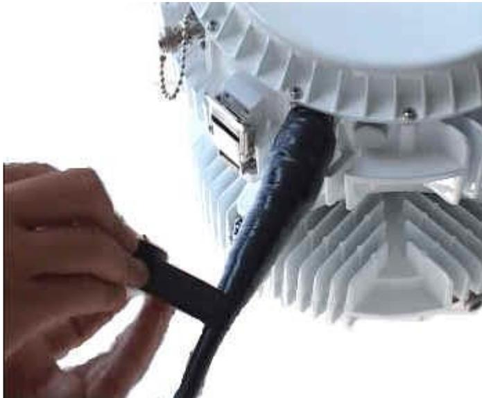
Figura 27. Envolviendo tres capas de cinta de PVC sobre la cinta aislante impermeable.
