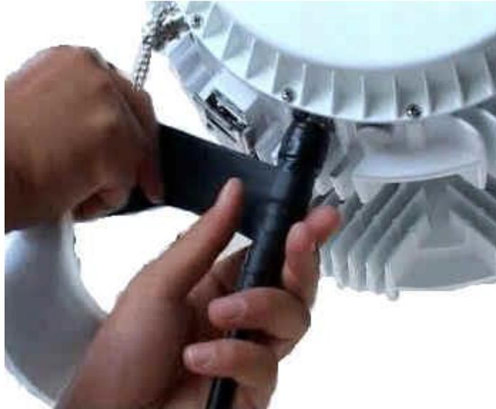
Figura 26 Envuelto tres capas de cinta aislante impermeable. Extraído de [11]
