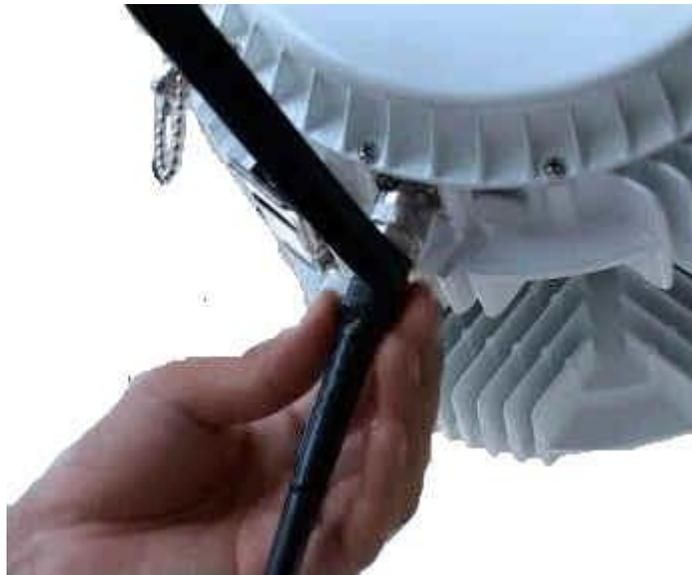
Figura 25 Envuelto una capa de cinta de PVC. Extraído de [11]
