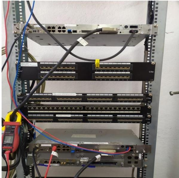
Para realizar estas pruebas se realizó un radio enlace Ipasolink con un arreglo 1 + 0
