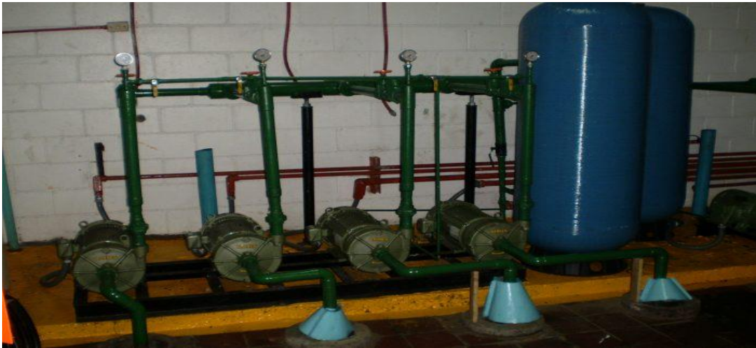
Figura 7 Hidroneumáticos múltiples
