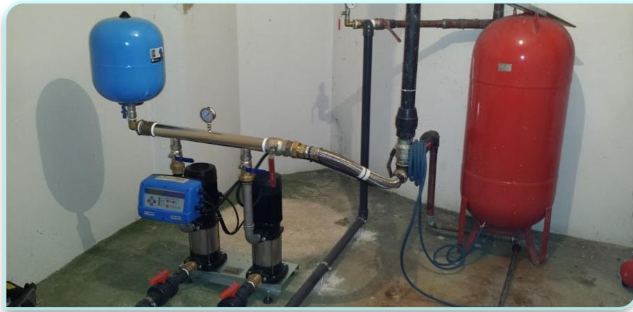
Figura 12 Ejemplo de sistema hidroneumático
