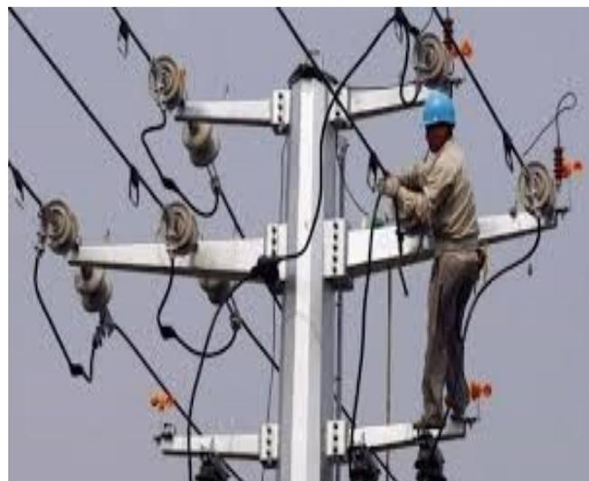
**FIGURA 1.5.2 INSTALACION AISLADORES TRANSMISION**
