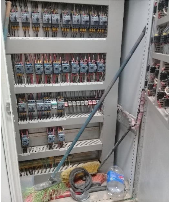
Sistema de control en area de molino, se puede observar la falta de mantenimiento dentro de este.
