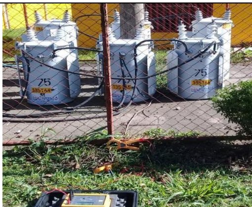
Ilustración 17. Medición PT transformadores y resultado.
