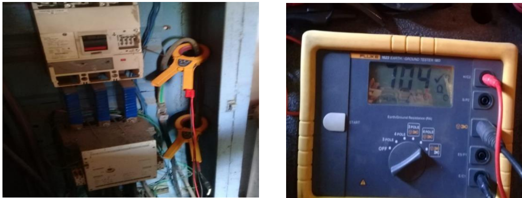
Ilustración 18. Medición de puesta a tierra paneles
