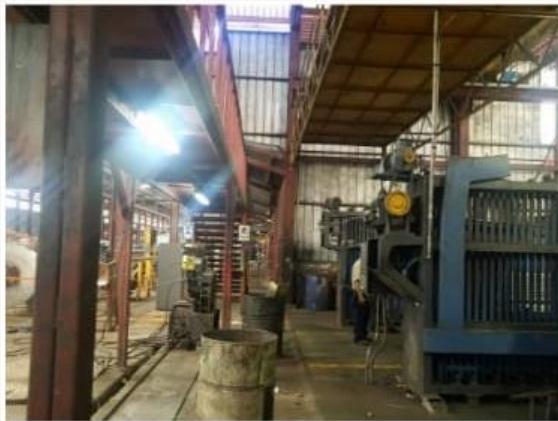
Ilustración 6: Tuberías con acumuladores verticales
