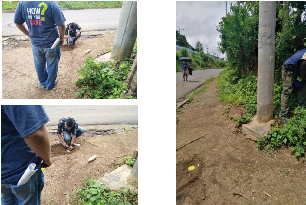
Figura B-10 Instalación del BM-3
