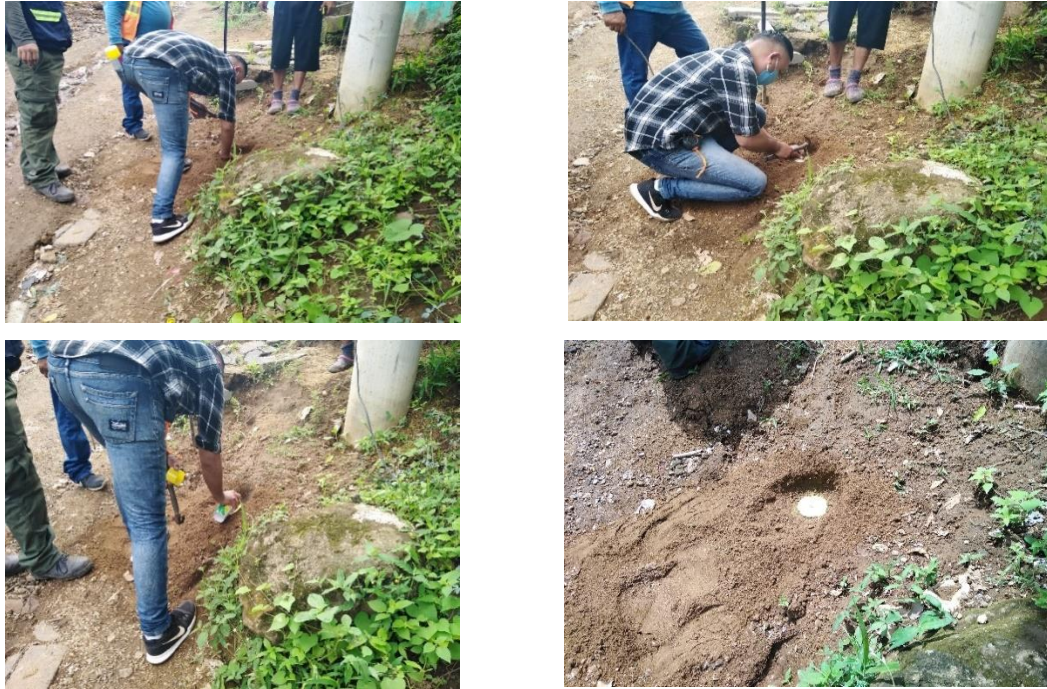
Figura B-9 Instalación del BM-5
