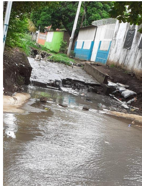
Ilustración 6 Extremo norte del cauce
