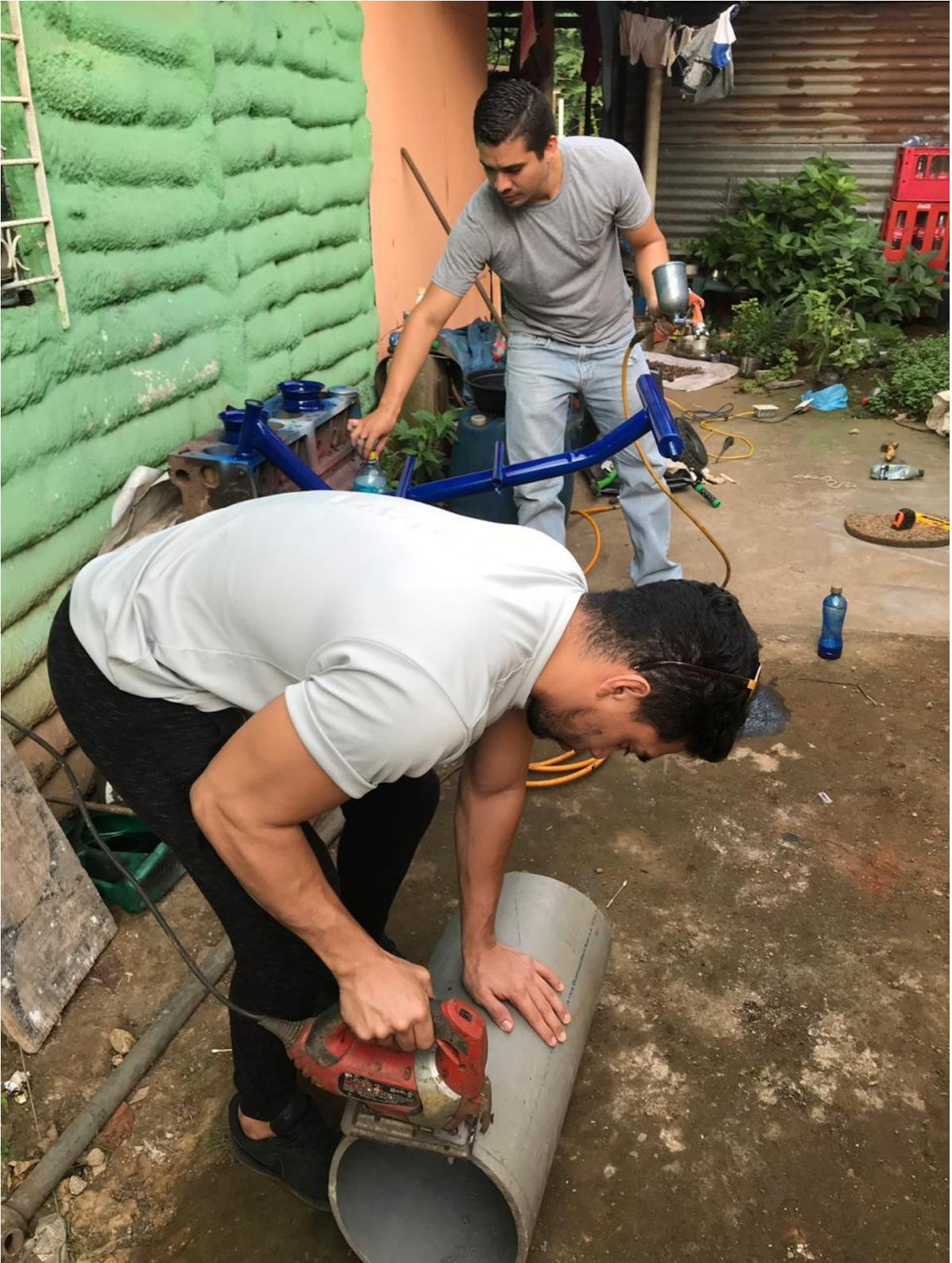
Realizando cortes del tubo pvc, el cual sera usado para revestir las llantas traseras.
