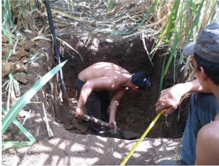
**Imagen 6.** Elaboración de calicata de 1.20 m largo, 1.50 m de ancho y 1.30 m de profundidad.
