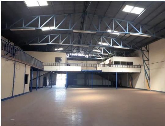
Figura 4.1 Vista panorámica del local.
