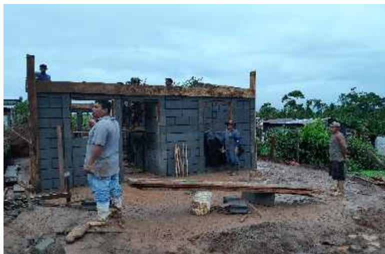
formaleta viga corona. Eje 1
