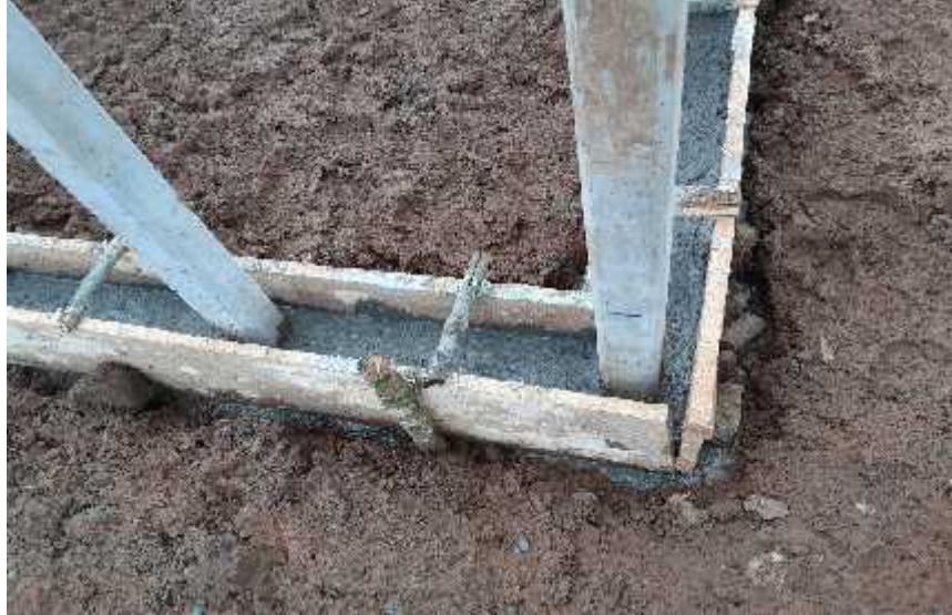
Formaleta y llena de concreto V-A Eje A
