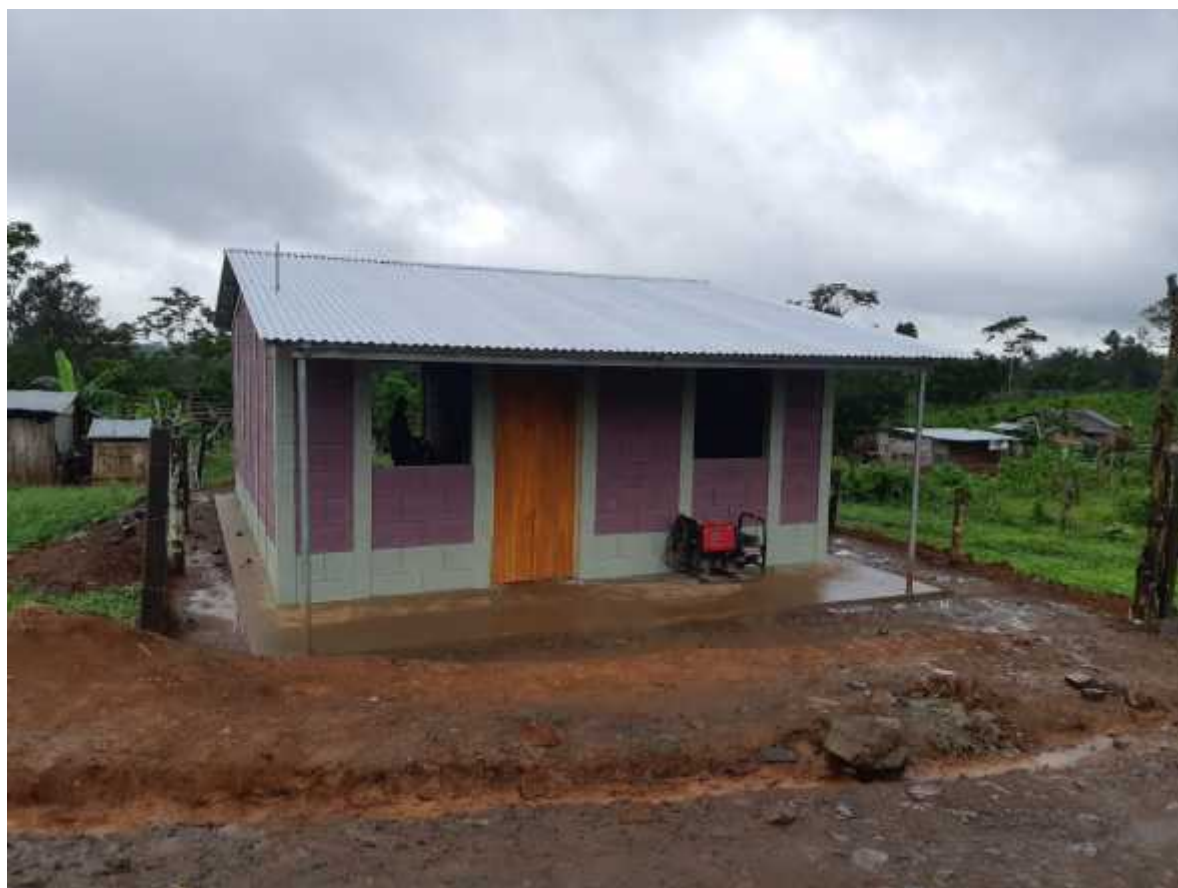
Vivienda terminada, colocación puertas y ventanas.
