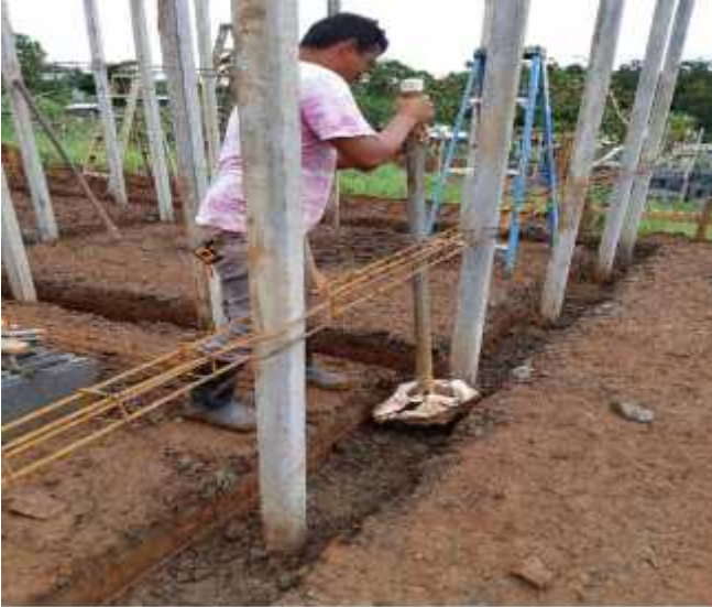
colocación viga Asismica. Eje 3
