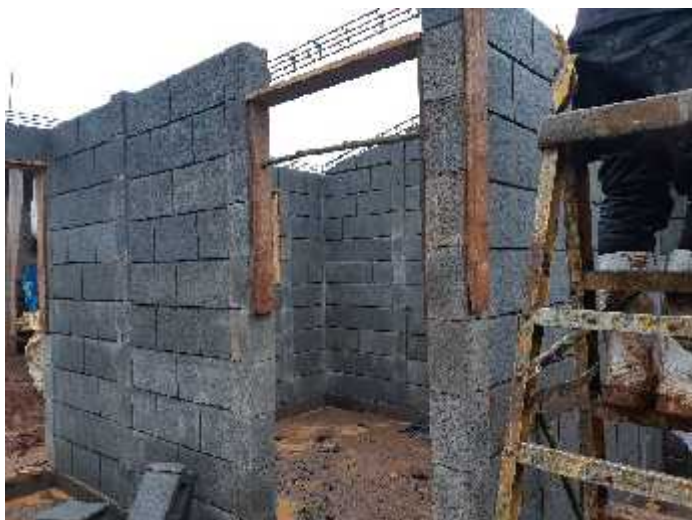
Colocación viga corona Eje B
