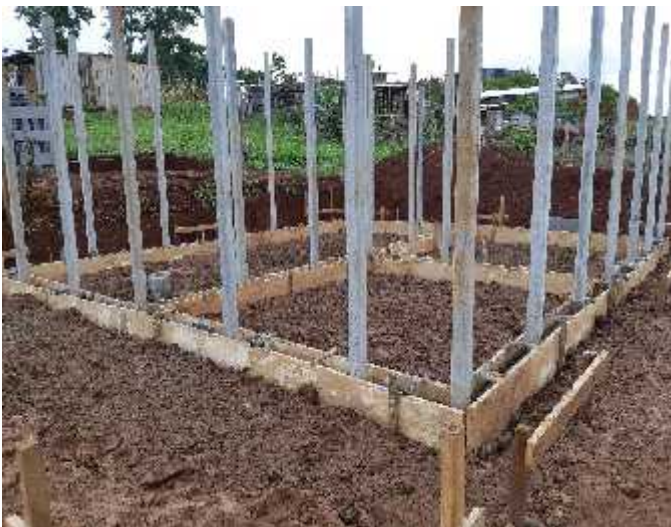
postes de concreto y formaleta V-A
