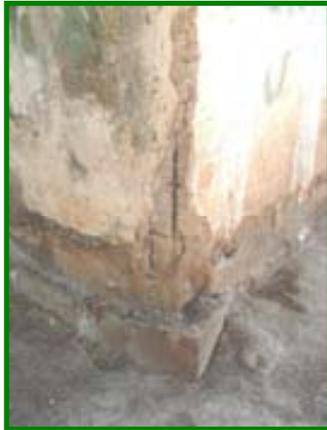
Puede notarse el estado de la columna de concreto en el pabellón 1, la cual presenta fisuras, descaramiento y corrosión en la estructura de acero.
