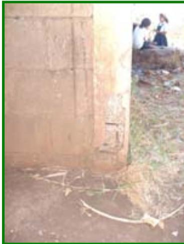
Puede notarse el estado de la columna de concreto en el pabellón 1, la cual presenta fisuras, descacaramiento y corrosión en la estructura de acero.
