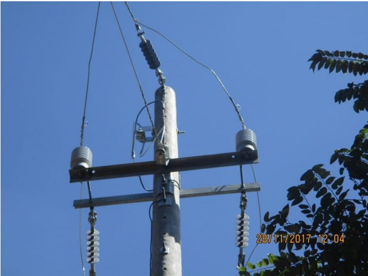
**Ilustración 7 Fin de línea punto de transición, Manual PRES 2017 Disnorte-Dissur**
