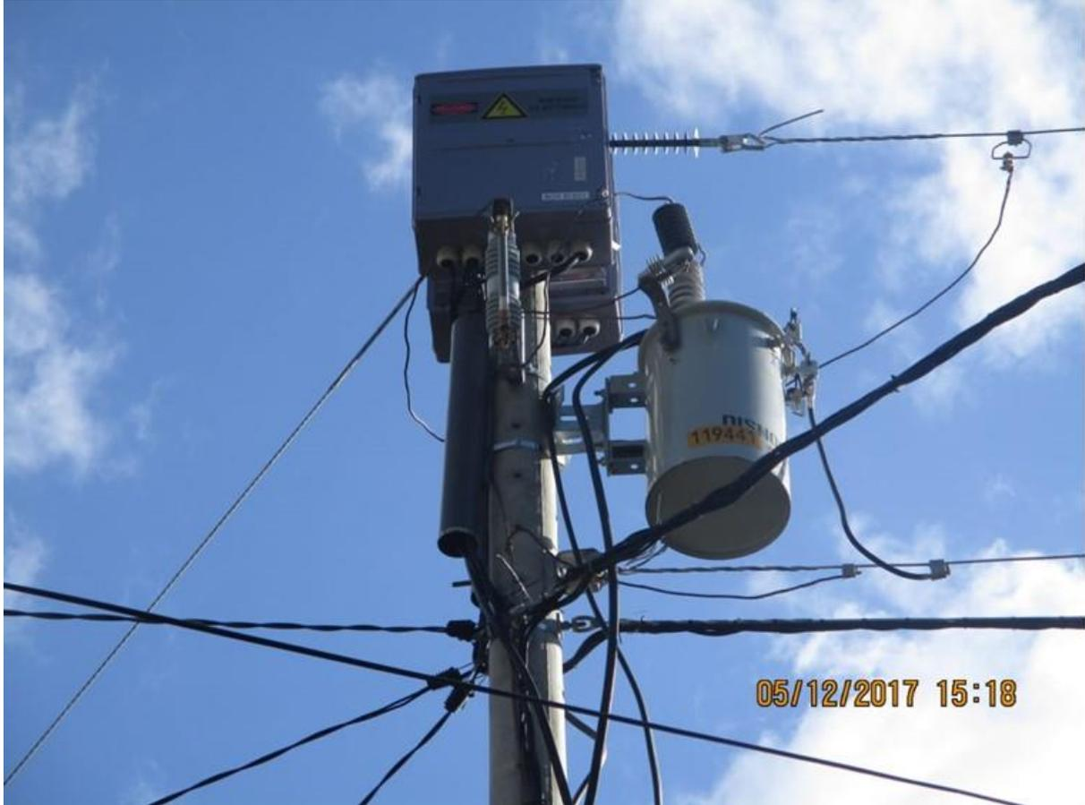
**Ilustración 4 Transformador en fin de Línea sin red de baja tensión, Manual PRES 2017 Disnorte-Dissur.**
