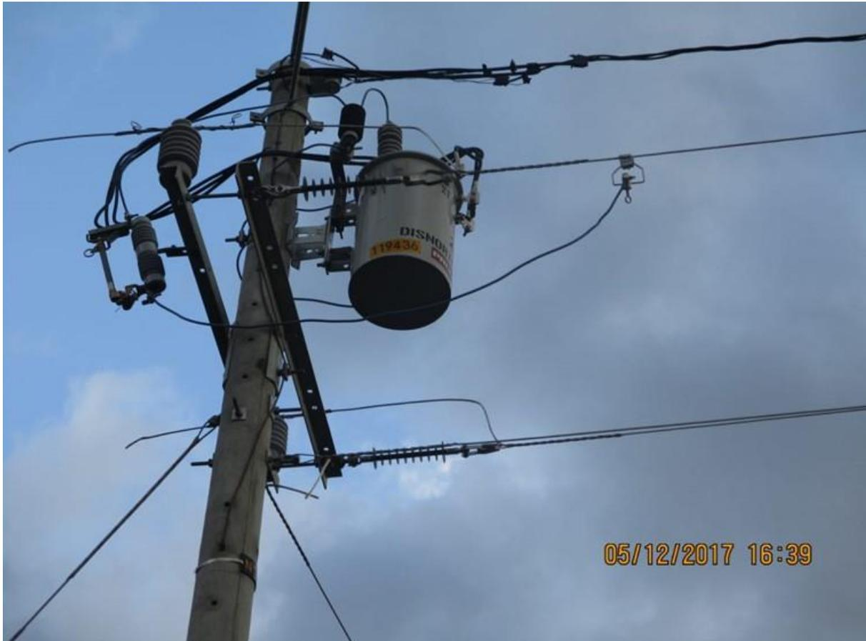
**Ilustración 5 Transformador en fin de Línea Red compacta, Manual PRES 2017 Disnorte-Dissur**
