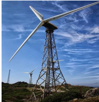
Figura 14. Torres en celosía
