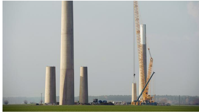
Figura 16. Torres de hormigón
