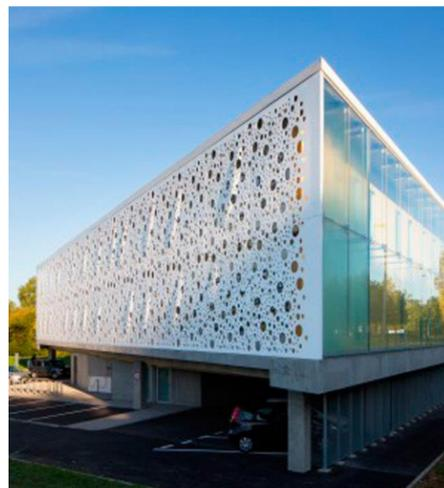
Foto No. 14: Estructura de doble piel con lámina perforada
